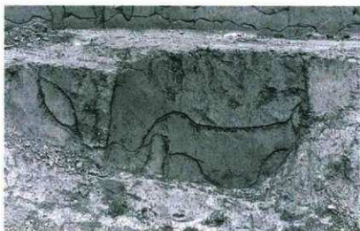
5. SK654J 東西土層断面 (北から)
