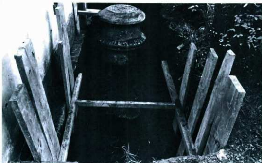
1. 1人孔調査区全景 (北より)
