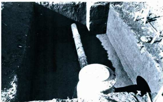
1. 5人孔調査区全景 (東より)
