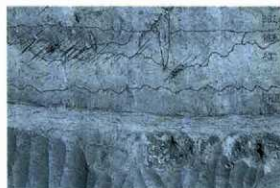
A区炭化物集中2 (西から)
