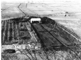
1 第1地区全景（東方より）
