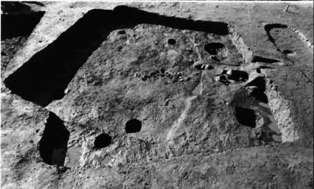
3 H25・26号 住居址 (東より)
