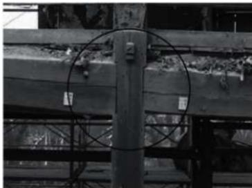
写真3-46 側柱と胴差の仕口「三方差し」
