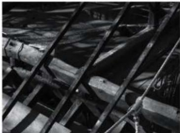
写真3-19 当初材の軒桁、小屋梁
