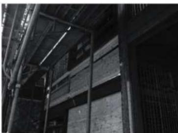
写真 4-79 補強壁（土壁を置換）、構造用合板張り
