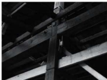
写真 4-76 階間間の柱補強
