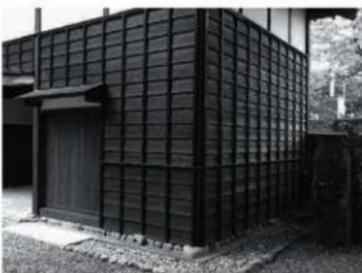
写真 4-52 下見板(廊の高さにある水切り柵は、整備として創設時の下見板高さを再現したもの)
