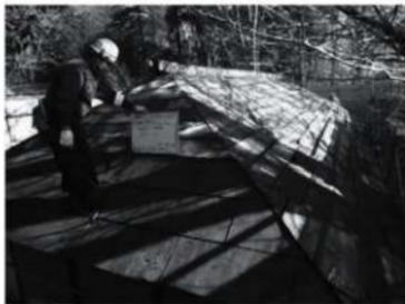
写真 4-14 屋根葺材（亜鉛鉄板）撤去
