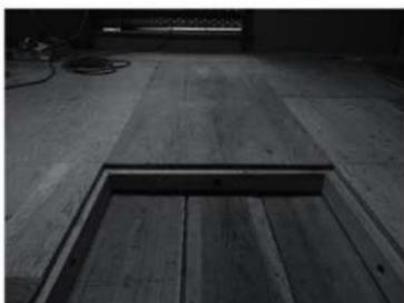
写真 4-81 二階床補強（下地+構造用合板 t24）
