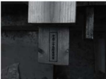
写真 4-40 補足材烙印 (平成 29 年度修補)
