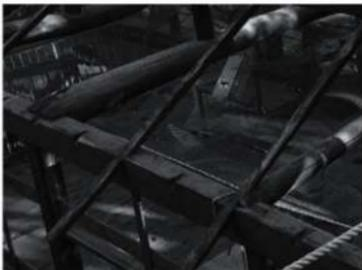
写真3-20 後補材の軒桁、小屋梁
