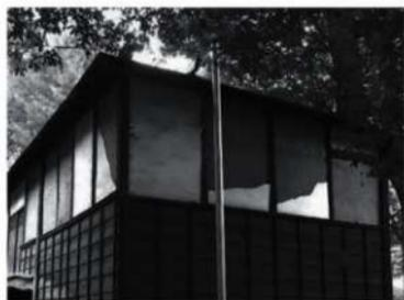
写真3-9 外壁：漆喰壁（西面、北面）
