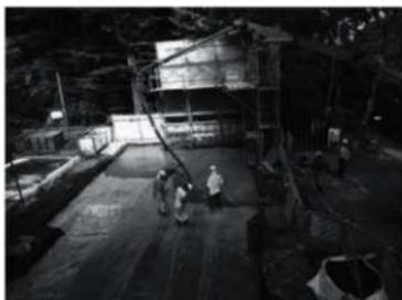
写真 4-32 捨コンクリート打設
