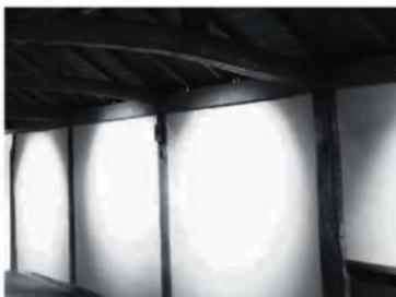
写真4-84 ビクチャーレール（軒桁上部）
