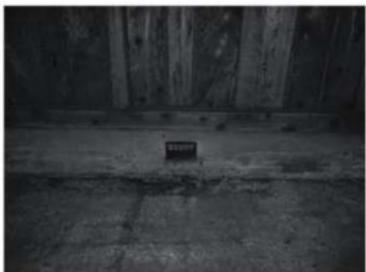
写真 3-72 コンクリート製の布基礎
