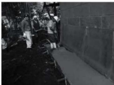
写真4-113 犬走り、コンクリート打設
