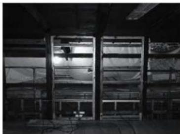
写真 4-78 補強壁（土壁を置換）、木下地
