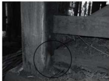
写真3-45 柱と土台の仕口、枘差し（へー八通り）
