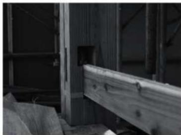
写真 4-74 基礎と柱の緊結
