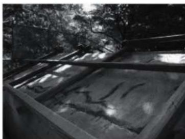
写真4-107 置き屋根、下地解体
