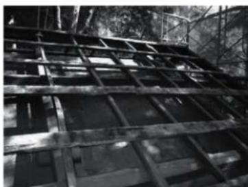
写真4-106 置き屋根、波板除去後
