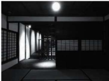
写真 4-73 板戸、障子の吊り込み (二階八畳)
