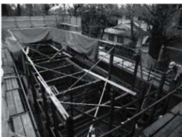
写真4-24 軸部の解体
