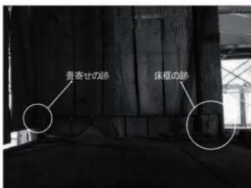
写真3-28 床框の仕口跡（右）と畳寄せの跡（左）
