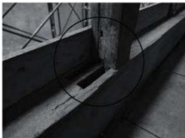
写真3-47 二階管柱の仕口「送りあり」
