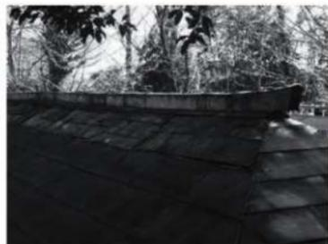
写真3-7 屋根：金属板、野地板（寄棟屋根）
