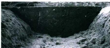
3. C-C'土層断面 (南から)
