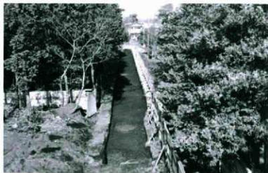
2. 道路部分（南から）
