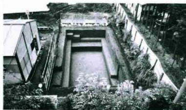
2. 浄化槽部分全景（南から）
