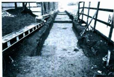
2. 道路部分（南から）
