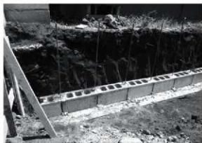
第12図 No.205 立会状況
