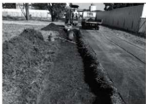
第9図 No.70 立会状況
