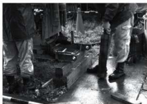
第6図 No.6 立会状況
