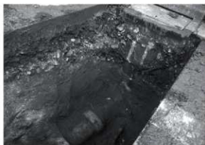
第8図 No.33 立会状況
