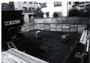
第11図 No.106 立会状況
