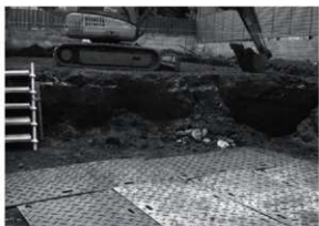
第7図 No.23 立会状況
