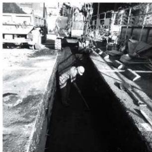
第93図 調査風景 遺構確認
