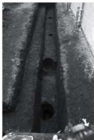
第40図 Aトレンチ全景 (西から)
