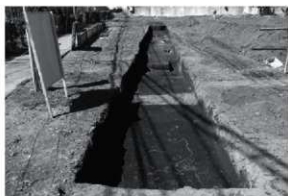
第80図 南トレンチ全景(東から)
