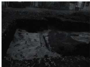
写真 28 Eトレンチ砂埋戻し状況（東から）
