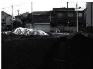
写真 16 調査区全景（北から）
