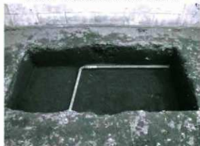
第60図 Bトレンチ全景(西から)
