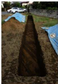
第123図 Aトレンチ全景(西から)
