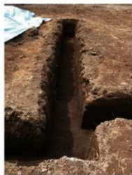
第85図 調査区南部（北から）
