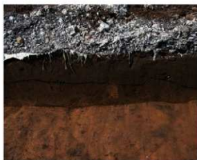
第41図 調査区土層断面（南から）
