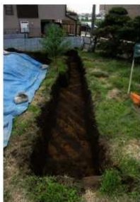
第125図 Cトレンチ全景(東から)
