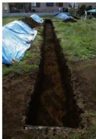
第124図 Bトレンチ全景(西から)
