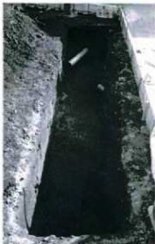
3. 87次調査区全景 北から
