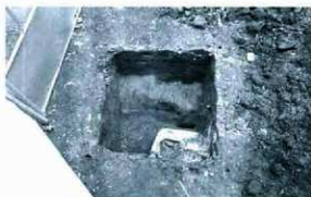
1. A トレンチ全景 西から
