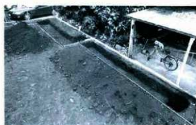
2. B,C トレンチ全景 東から
