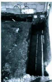
2. Bトレンチ全景 南から
