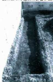
1. A トレンチ全景 西から
