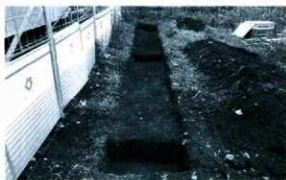
1. A トレンチ全景 西から
