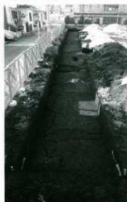
1. A トレンチ全景 南から
