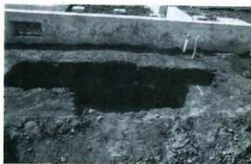
1. 調査区全景 (北から)
