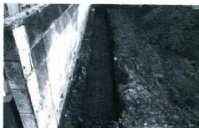
3. Cトレンチ全景(東から)
