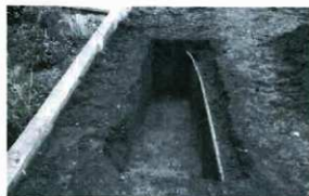
2. 調査区全景 (北から)
