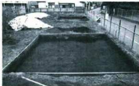
2. B トレンチ全景 (西から)
