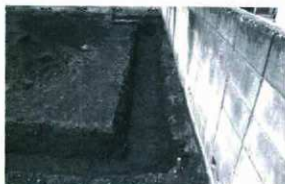
2. Bトレンチ全景(北から)
