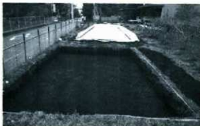
3. C トレンチ全景 (東から)
