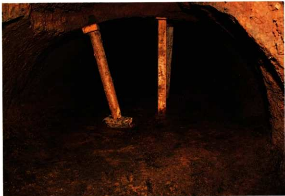
I Z 5号窯址焼成部（焚口より）
