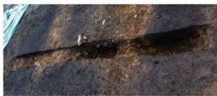
トレンチ断面（東から）
