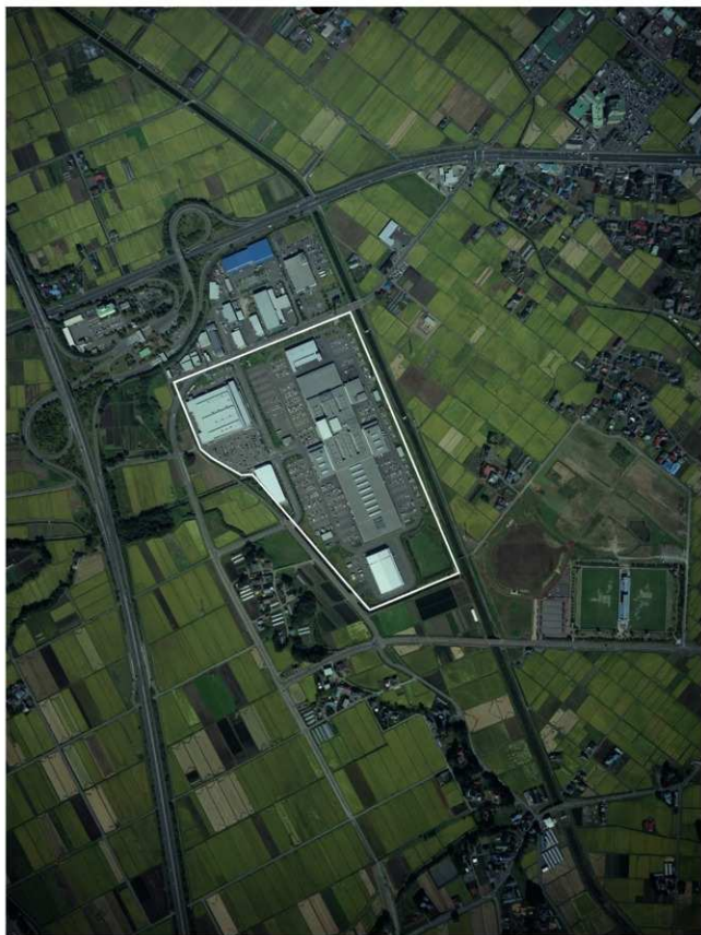
第1図版 盛岡市中央卸売市場航空写真(白線は新市場整備範囲, 平成20年(2008)9月30日撮影)
