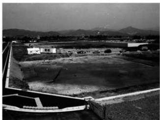
第4次調査M区全景(北西から)
