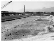
第4次調査R-S区全景(東から)
