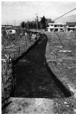
4 Bトレンチ完掘状況（北方より）
