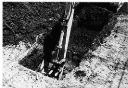
2 Bトレンチ深掘り状況 (南西より)
