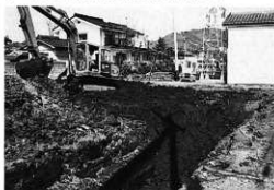
6 Bトレンチ埋め戻し状況 (南西より)
