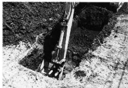
2 Bトレンチ深掘り状況 (南西より)
