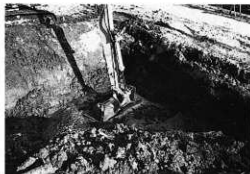
4 第1号溝状遺構掘り下げ状況 (南西より)
