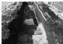
2 Aトレンチ完掘状況（西方より）
