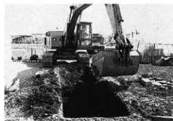
3 Bトレンチ表土削平作業（北方より）
