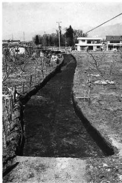
4 Bトレンチ完掘状況（北方より）
