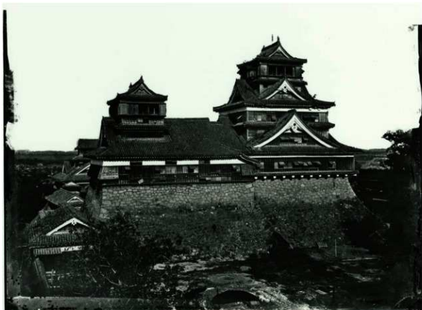
写真6 宇土櫓望楼から大小天守を望む（富重写真所蔵）・（s-6）
