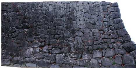
図3 熊本城明治22年被災箇所修復石垣
