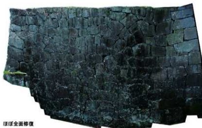
図2 熊本城明治22年被災箇所修復石垣【1-①-a類】横目地が通らない谷積みで新補石材を用いた石垣（赤点線より上部）
