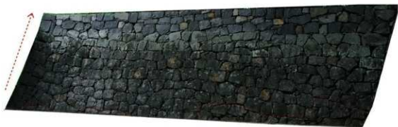
図5 熊本城明治22年被災箇所修復石垣
