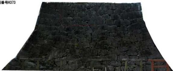
図6 熊本城明治22年被災箇所修復石垣
