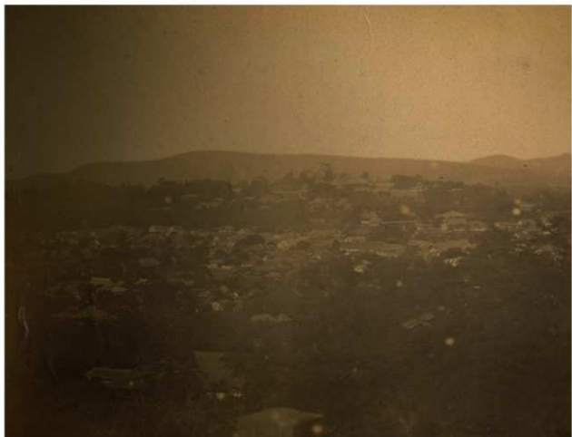
写真 11 花岡山から熊本城を望む (長崎大学附属図書館提供)
