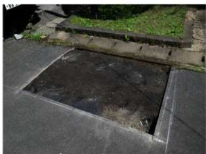
精算機 掘削状況（南から）
