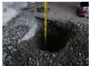
地点2 フェンス基礎A 掘削状況
