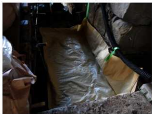
南側礎石石垣養生作業状況
