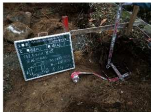
擬木フェンス基礎掘削状況
