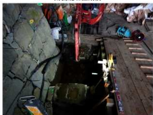
南側礎石掘削作業状況
