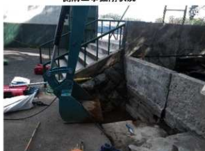
集水枡工事掘削状況
