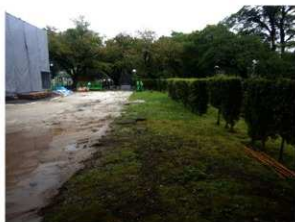
東側工事掘削前状況（南から）
