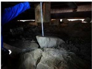
礎石No.4(東から)
