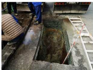
1地点 掘削状況
