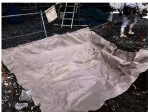
土木シートによる養生作業
