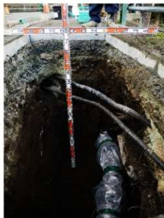
2地点 掘削状況（西から）
