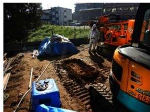
工事箇所遠景（北から）
