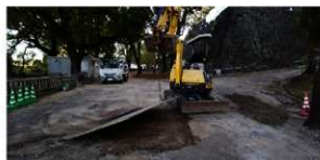
埋め戻し後鉄板養生作業
