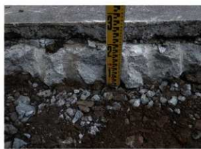
側溝掘削土層断面
