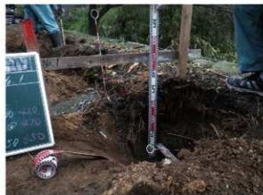
擬木フェンス基礎掘削土層断面
