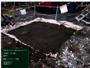
埋め戻し作業
