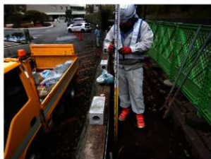
支柱設置に伴う掘削箇所（北から）
