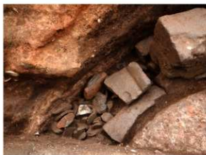
調査地1 石垣裏込状況(南から)
