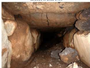
水路内部状況 北から
