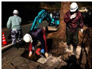
樹木周辺石敷撤去状況
