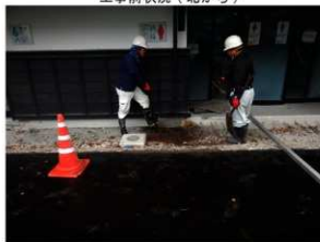
工事状況（東から）
