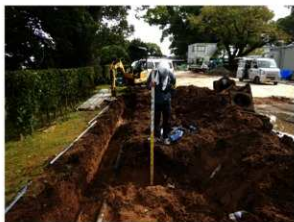
地点 2-Ⅲ 掘削状況（北から）
