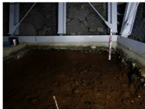
エレベータービット掘削後
