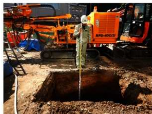
掘削状況（東から）
