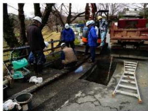
掘削状況（東から）
