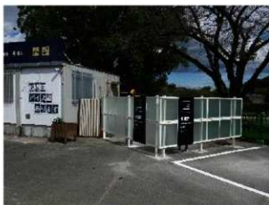
設置状況（南西から）
