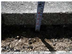
掘削状況（南から）
