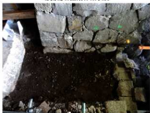
北側礎石掘削後
