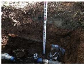
地点1 土層断面(西から)
