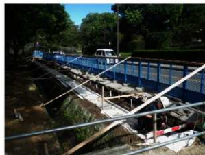
現地状況（東から）
