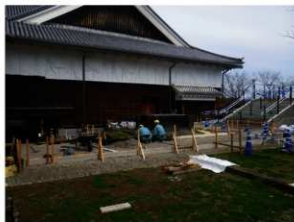
大御台所部分施工状況（南西から）
