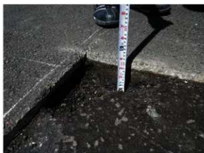
掘削状況（南から）
