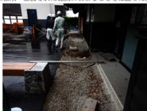
工事前状況（北から）
