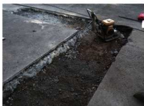
側溝工事掘削状況
