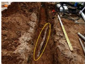
既設配管検出状況 (南から)
