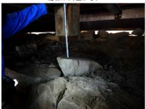
礎石No.3(東から)
