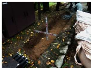
現地状況（北から）
