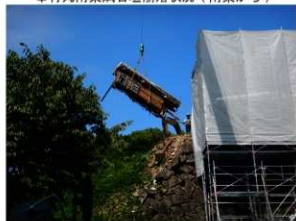
倒壊・崩落壁 回収工事風景（東から）
