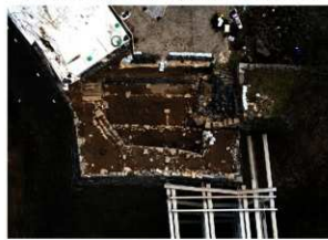
調査後状況(上が南)
