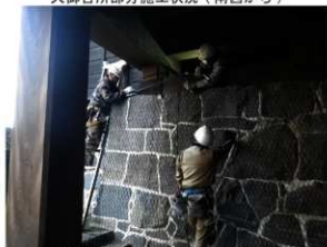
樹脂製ネット設置工事（西から）
