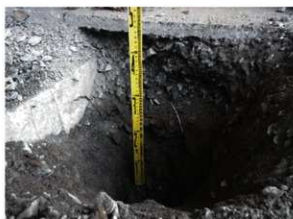
地点2 フェンス基礎A 土層断面
