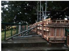
フェンス基礎工事 (南西から)
