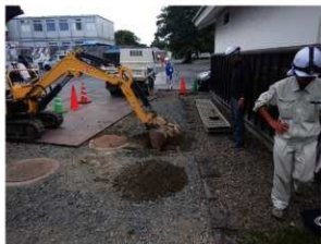
掘削状況（南から）
