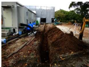
既設配管検出箇所周辺掘削状況 (南から)
