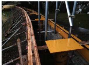
フェンス基礎工事状況
