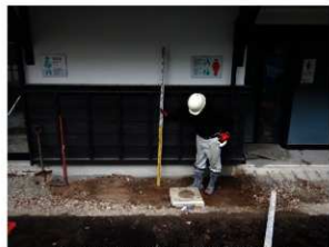
すき取り完了状況 遠景（東から）
