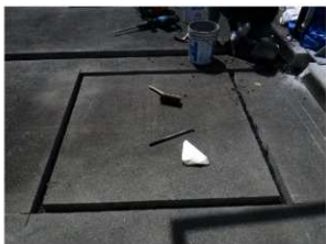
車両検知器 掘削状況（南から）
