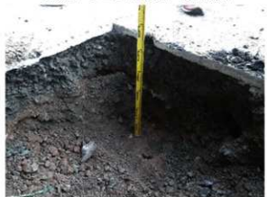
地点2 フェンス基礎B 掘削状況
