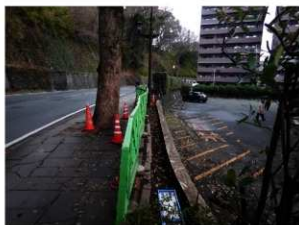
工事箇所遠景（南から）
