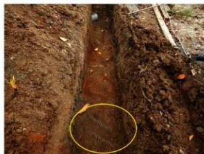
既設配管検出状況 (南から)
