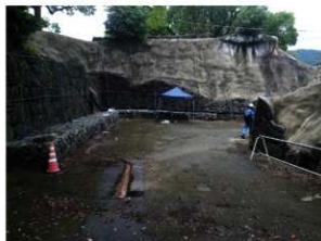
現地状況（東から）
