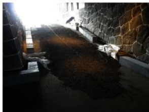
間り通路施工状況（北から）
