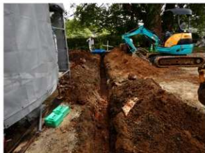
地点 2-Ⅴ 周辺掘削状況 遠景（西から）
