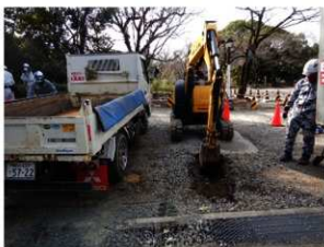
地点Ⅱ・Ⅲ掘削前周辺状況（北から）
