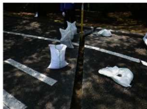
地点1 掘削状況(北から)
