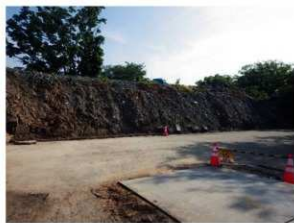
西大手 H42 崩落石材回収後 (北東から)
