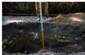
旧3番柵撤去状況 (北から)
