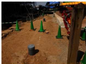
大天守前配管設置状況
