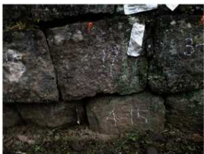
工事⑤施工状況 ナンパリングと墨付
