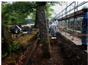
工事③施工状況 立て起こし作業中の柱と被災した柱
