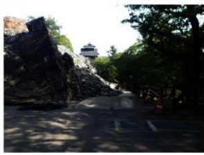
西大手門 H3 崩落石材回収後(北から)
