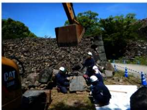
崩落石材回収作業実施状況
