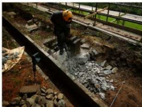
工事①施工状況 掘方整形 既存コンクリート基礎破砕
