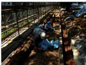
工事①施工状況 掘方最終整形
