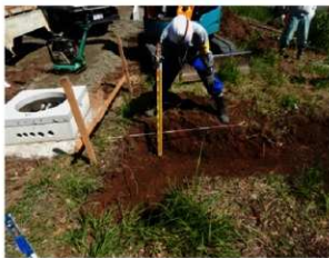
完掘状況（南から）
