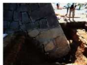
石垣立面（西から）
