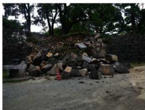
東竹之丸 H214 被災状況 (西から)
