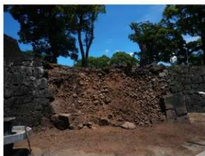
東竹之丸 H214 崩落石材回収後 (西から)
