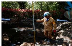
旧4番柵撤去状況(北から)
