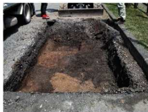
1トレンチ (南から)
