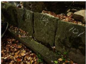
工事④施工状況 ナンバリングと墨付
