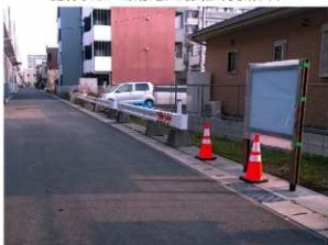
施工状況 発掘の成果解説板と平面標示（史跡内）
