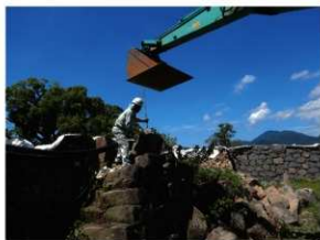
回収作業状況
