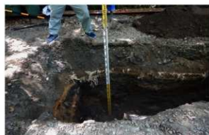
旧2番柵撤去状況 (北から)
