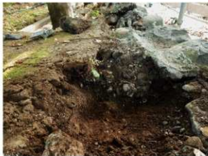
基礎石土台部断面 基礎No.6 東壁付近（西から）
