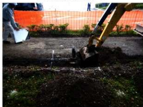
4地点掘削作業（南から）
