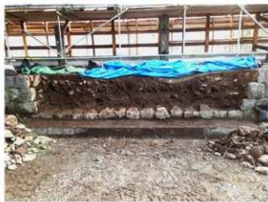
工事⑤施工状況 解体と背面整形完了後（北から）
