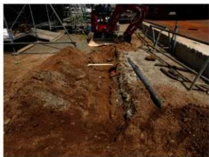
大天守前掘削状況
