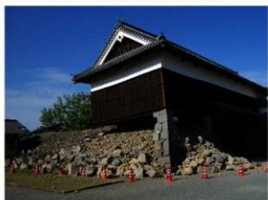
西大手門 H39-40 被災状況 (北東から)
