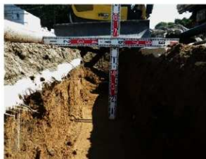
7地点土層断面（北から）
