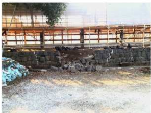
工事⑤施工前状況（北から）
