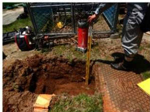
地点2 完掘状況(東から)
