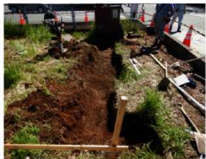
完掘状況（西から）
