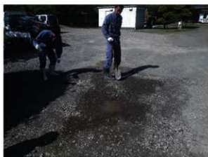
現地状況 掘削前（東から）
