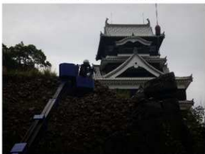
危険石材解体実施状況
