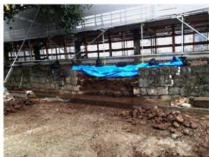
工事⑤施工状況 崩落石材除去後（北西から）
