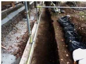
工事⑥施工状況 対象地中央付近掘削等完了後（東から）
