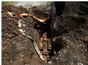
掘削状況（西から）
