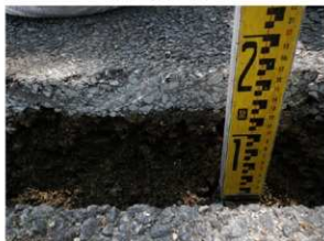
地点1 掘削断面(西から)
