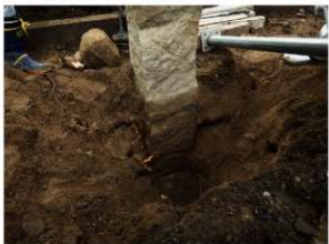
工事③施工状況 控柱周囲の掘削
