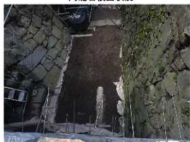
埋め戻し状況
