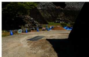
新規6番柵施工 完工状況 遠景(南から)
