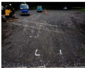
地点2 掘削前状況（東から）
