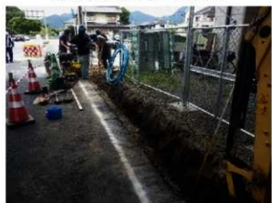
掘削状況（東から）（史跡外）
