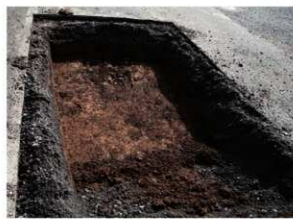
3トレンチ（西から）
