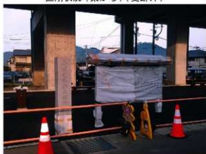
施工状況 解説板と標柱（史跡内）
