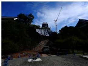
安全対策工事実施状況
