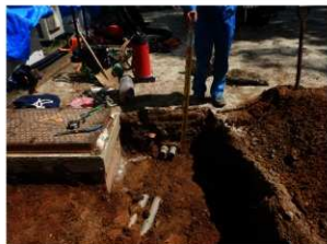
地点1 完掘状況(南から)
