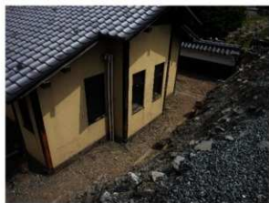
H39 トイレ裏崩落石材回収後 (北西から)
