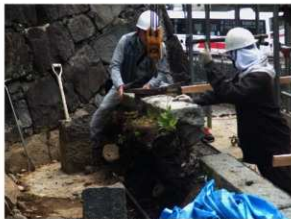
工事②施工状況 基礎石取り外し
