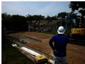
崩落石材測量状況
