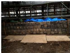
工事④施工状況 工事完了（北から）
