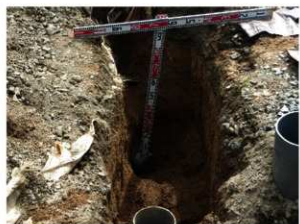
御裏五階櫓前掘削後
