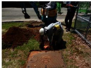
地点2 掘削作業中(北から)
