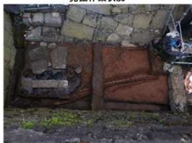
電線検出状況
