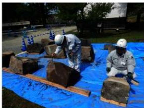
石材回収ナンバリング実施状況
