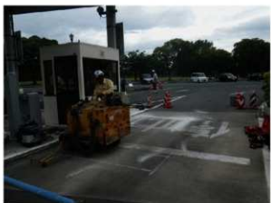
現地状況（南から）
