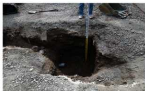
旧6番柵撤去状況(西から)
