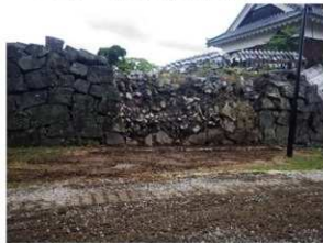
西出丸 H81 崩落石材回収後 (東から)
