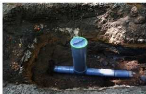
新規3番柵設置状況(北から)
