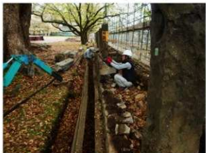
工事④施工状況 解体
