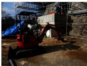
大天守附櫓前掘削状況
