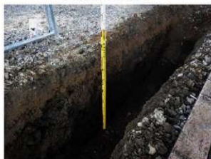
掘削状況（南から）（史跡外）
