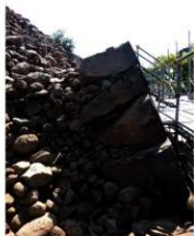
江戸期当初(五階槽台構築時) の築石と裏込め
