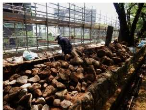
工事①施工状況 栗石の掘り起こし
