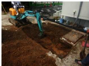
地点1 掘削作業中(北東から)
