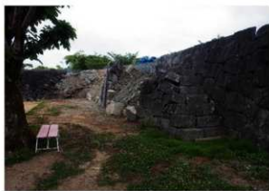
奉行丸 H34・35 崩落石材回収後(南東から)
