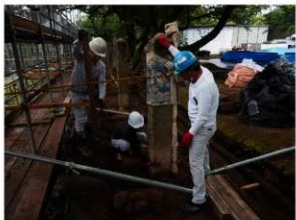
工事③施工状況 立て起こし作業
