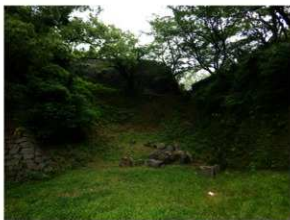
数寄屋丸 H307 崩落石材（西から）
