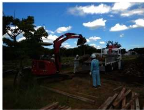
石材仮置き作業状況
