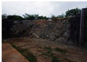
奉行丸 H33・34 崩落石材回収後(南東から)
