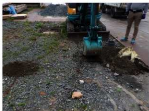
御裏五階櫓前掘削状況
