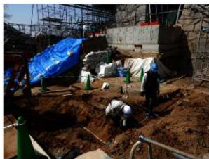
大天守附櫓前配管撤去作業
