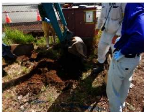
掘削作業状況（西から）
