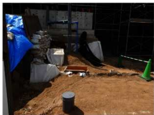
大天守附櫓前配管設置状況
