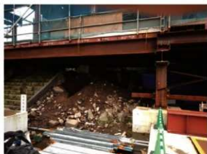
調査前現況 東から
