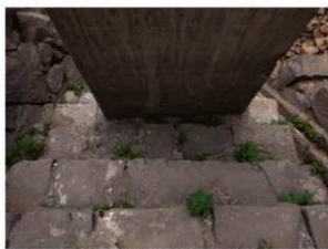
橋脚中段掘削前状況 西から
