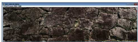
(a) 画像解析ソフトにより加振伝播速度の測定範囲で切り取った石垣の画像
