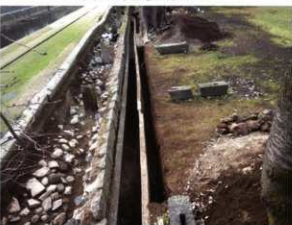
トレンチ9-3・9-2完掘状況 東から
