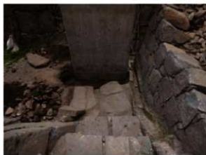
橋脚下段西側掘削後状況 西から
