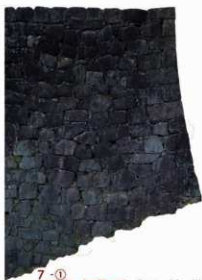
7-1 1702年(元禄15) 方形石材で横目地通りやすい慶長後前期頃の石垣(方形石材で横目地通りやすい)に対して修復
