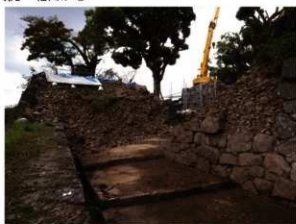
不開門虎口崩落石材回収後状況 北西から
