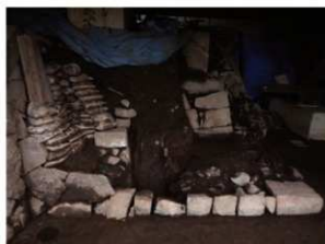
崩落石材回収状況 東から
