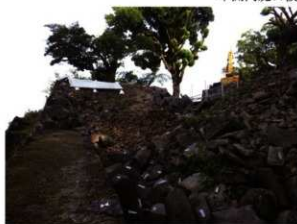
不開門虎口被災状況 北西から
