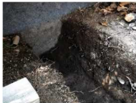
1トレンチ 石垣検出状況 北東から
