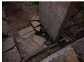
橋脚下段西側仮埋め戻し状況 南西から
