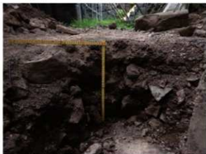
橋脚下段西側北壁断面状況 南から
