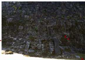
2 1640年(寛永17) 方形石材で横目地通りやすい慶長後前期頃の石垣(方形石材で横目地通りやすい)に補強石垣として増築【赤矢印】
