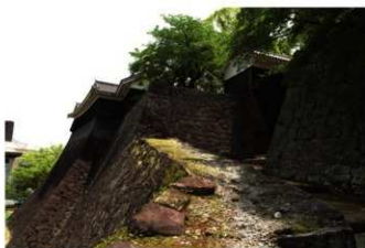
不開門虎口被災前状況 北西から
