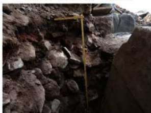
橋脚上段北壁断面状況 南から
