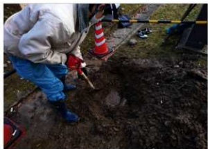
A地点掘削状況 北から
