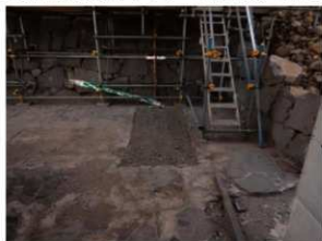
支持力試験箇所埋め戻し状況 北から
