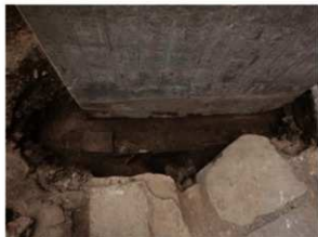
橋脚下段西側掘削後状況 西から
