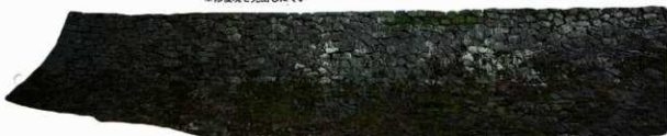
17-① 1796年（寛政8）方形石材で横目地通りやすい、部分的に谷積みあり 慶長前半期築の石垣（非方形石材で横目地通りにくい）に対して修復
