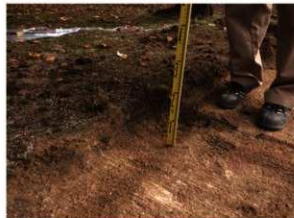
仮設建物基礎掘削深度把握状況 南西から
