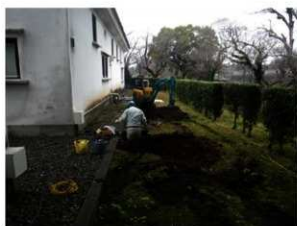
A・B地点 南から
