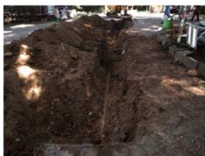
1地点 掘削後状況 西から
