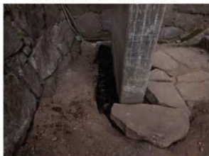
橋脚下段東側仮埋め戻し状況 北から
