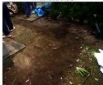
埋め戻し完了状況
