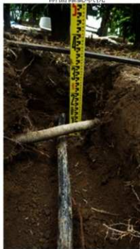
断面確認状況
