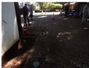
1地点 掘削前状況 西から
