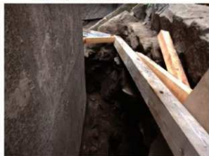
橋脚中段南壁断面状況 北から
