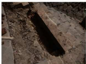
橋脚上段掘削後状況 南西から
