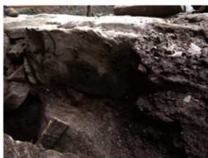
橋脚下段石敷き下部状況 東から
