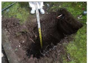
C地点掘削状況 南から
