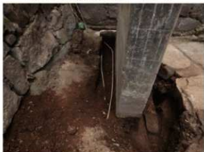
橋脚下段東側掘削後状況 北から
