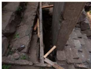
橋脚中段掘削後状況 南から
