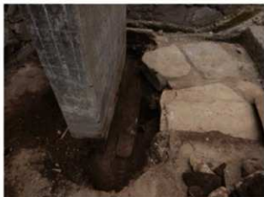
橋脚下段西側掘削後状況 北から
