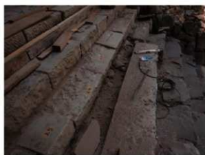
橋脚上段掘削前状況 南から
