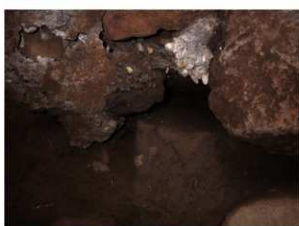
1-2トレンチ 控柱№7破断部 東から
