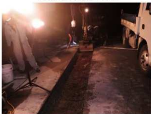
2地点 掘削後状況 東から
