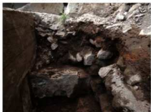
橋脚上段南壁断面状況 北から
