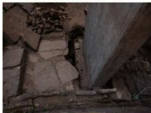
橋脚下段西側掘削後状況 南から
