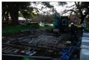
現地状況 北から
