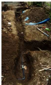
水道管掘削状況 北から
