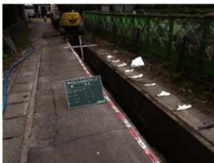
掘削状況 西から
