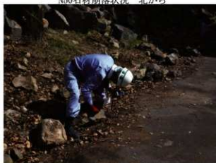
崩落石材番付作業実施状況
