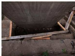
橋脚中段掘削後状況 西から
