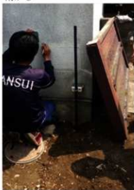
水道管を地上に立ち上げ新設
