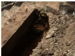
橋脚上段南壁石材検出状況 北西から
