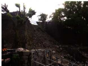
本丸石垣H416被災状況 北東から
