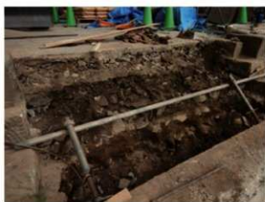
橋脚上段石段解体状況 南東から
