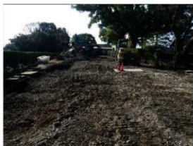
現地状況 北から
