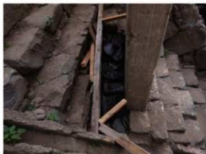
橋脚中段仮埋め戻し状況 南から
