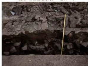
橋脚上段西壁断面状況 東から
