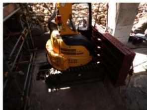
支持力試験状況 東から
