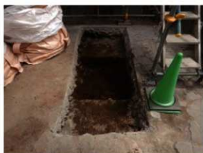
支持力試験箇所掘削後状況 北から
