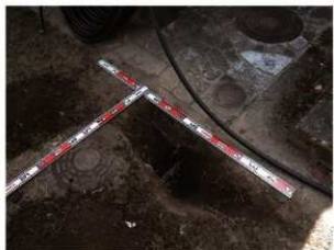
C地点状況 北西から
