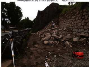
測量作業実施状況
