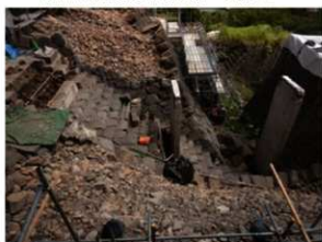
橋脚掘削後全景状況 南から
