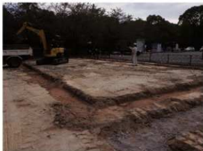
仮設物基礎掘削箇所全景 北東から
