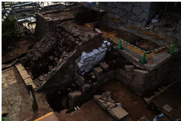
大天守附櫓周辺石垣解体後状況 北東から(江戸期の附櫓台石垣検出状況)
