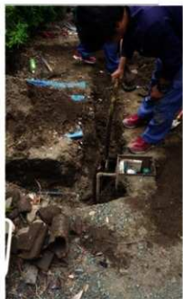
水道管掘削状況
