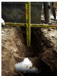
断面確認状況
