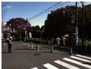
現地状況 南西から
