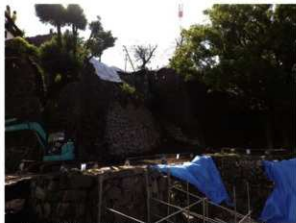
本丸石垣H416崩落石材回収後状況 北東から
