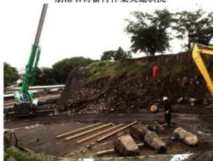
崩落石材回収作業実施状況
