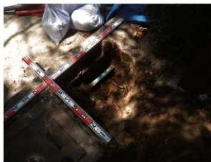
A地点状況 南東から
