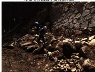
崩落土除去作業実施状況
