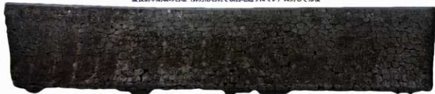
16-② 1790年（寛政2）方形石材で横目地通りやすい 慶長後半期築の石垣（方形石材で横目地通りやすい）に対して修復 ※修復境を見出しにくい
