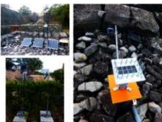
写真-2 各機器類の設置状況
