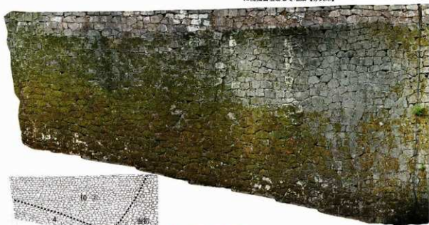
4 1649年(慶安2) 長方形石材で地形に即した横目地あり 10-2 1719年(享保4) 正方形石材で水平横目地あり 慶長前中期頃の石垣(非方形石材で横目地通りにくい)に対して修復
