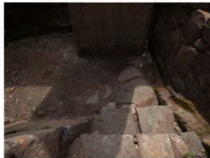
橋脚下段西側掘削前状況 西から
