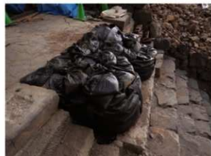
橋脚上段仮埋め戻し状況 南東から
