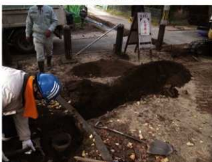
公園内部掘削状況
