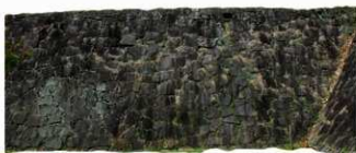
16-① 1790年（寛政2）方形石材で横目地通りやすい 慶長前半期築の石垣（非方形石材で横目地通りにくい）に対して修復
