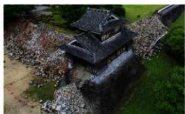
写真-2 崩壊の様子 1)
