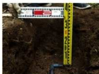
断面確認状況
