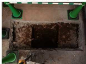
支持力試験箇所掘削前状況 西から
