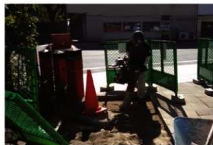
トレンチ埋戻し時の転圧作業
