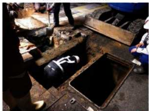
既設管の切り替え作業
