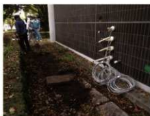
敷石撤去前 南から
