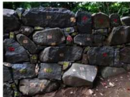
写真 30 積直し後拡大④ (南東より)
