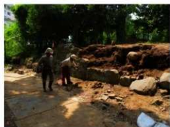
写真 35 石垣取り外し状況 (北東より)
