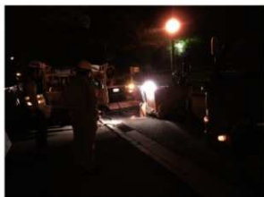
5月26日施工前舗装切断状況 北西から
