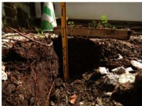
基礎コンクリート除去後の最深部 北西から
