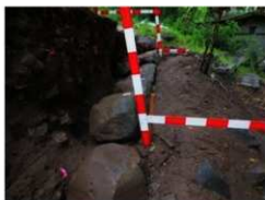
写真 19 1 段目積直し後 (南より)
