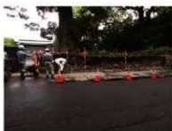
P1 工事中 南から
