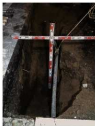
土層断面確認 (10/17)
