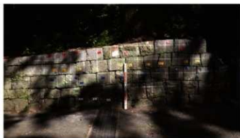
P1 工事前 西から
