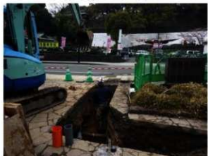
既設管の切り替え作業
