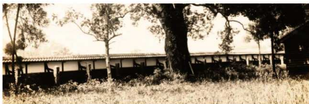
図3 昭和4年時点の長塀背面 塀と控柱石を繋ぐ筋違いがみられる (昭和4年熊本城史蹟請願書写真)
