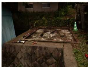
基礎コンクリート撤去後状況 南西から
