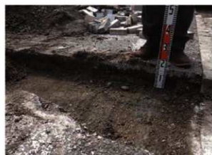
基礎部分掘削
