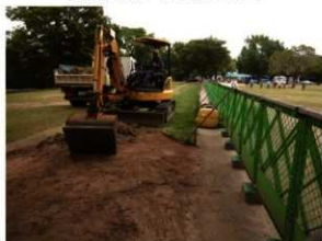
掘削作業状況 北から
