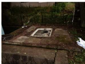
整圧器撤去後状況 南から
