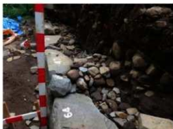
写真 20 2 段目積直し後 (北東より)
