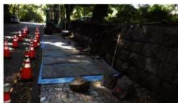
P1 石積の解体 東から
