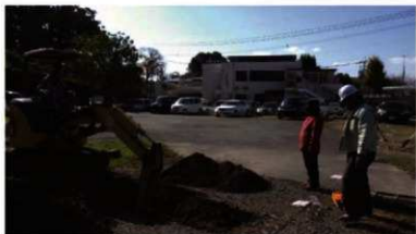
5トレンチ調査風景
