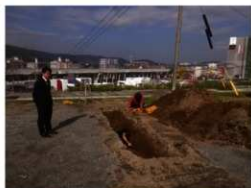
1トレンチ調査風景
