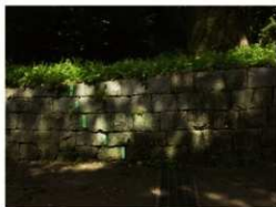
P1 工事前 西から
