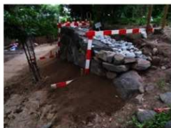
写真 21 積直し後（北東より）
