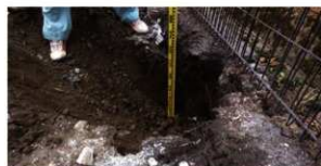
工事掘削状況
