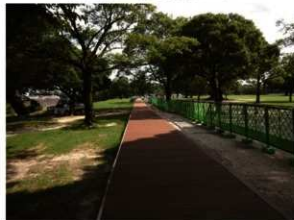
通路整備工事完了状況 北側付近 北から
