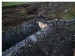
工事終了 南東から
