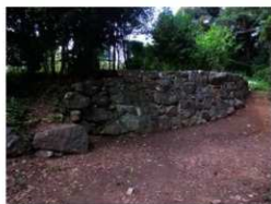
写真 25 積直し後全景①（南より）
