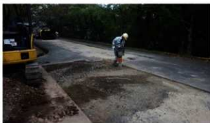
トレンチ1 埋め戻し状況
