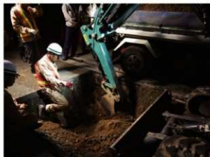
掘削状況 南東から
