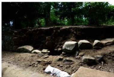
修理箇所解体状況
