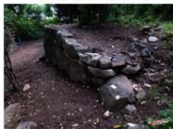
写真 23 積直し完了全景（北東より）
