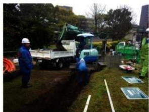
新設箇所の掘削状況
