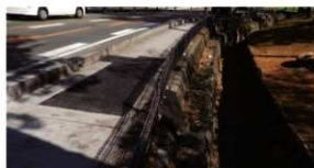
工事終了後の状況
