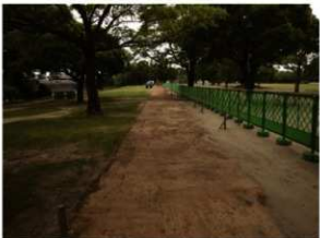
掘削後状況2 北側付近 北から
