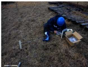
東京大学総合博物館 地割れモニタリングセンサー設置
