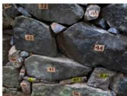
写真 22 積直し後の逆石 No. 43（南東より）
