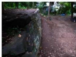
写真 24 積直し完了天端（南西より）
