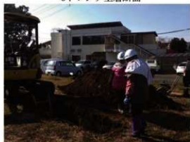
9トレンチ調査風景
