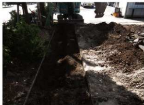
上下水道部分掘削
