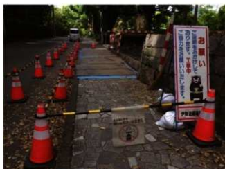
P1 工事中 東から
