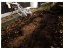
敷石撤去後 北から
