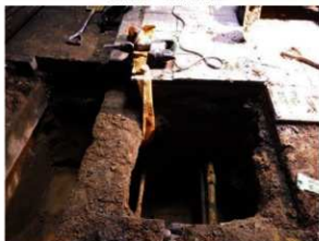
既設管の土層断面
