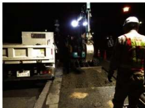
掘削開始状況 西から
