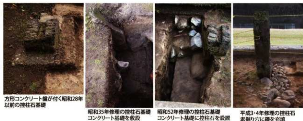
図7 長堀の控柱石基礎の種類
