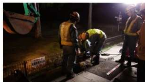
夜間工事風景 (10/25)
