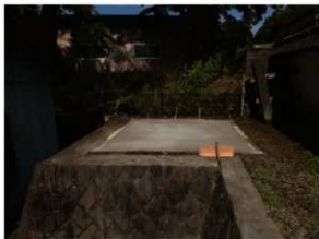
工事終了後状況 南西から
