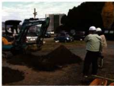
8トレンチ調査風景
