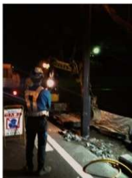
夜間工事風景 (10/17)
