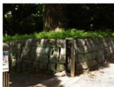
P1 工事前 南西から
