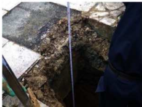
既設管の土層断面
