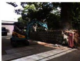
P1 削岩機でセメント部分を撤去 西南から
