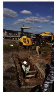
4トレンチ調査風景
