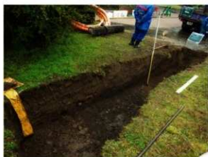
新設箇所の掘削状況
