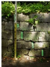
P1 工事前 西から
