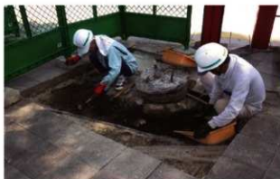
人力による掘削作業
