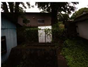
7月12日整圧器撤去状況 南西から
