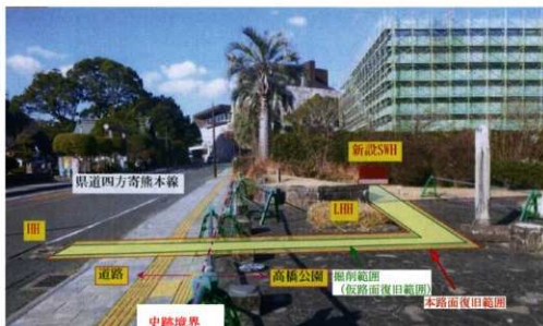
掘削箇所 全景
