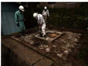
基礎コンクリート撤去作業状況 南から
