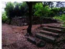
写真 26 積直し後全景②（北東より）
