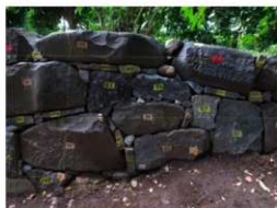
写真 33 積直し後拡大⑦ (南東より)
