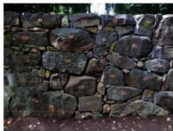
写真 29 積直し後拡大③ (南東より)
