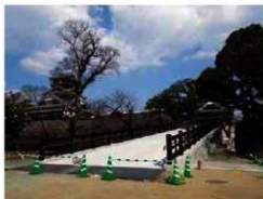
天守閣復旧へのスロープ設置
