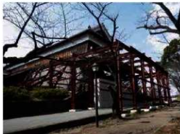
南大手門櫓門の倒壊防止工事
