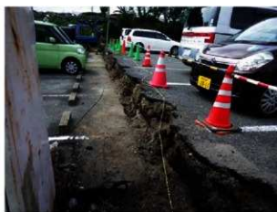
(12) 工事風景（東から）
