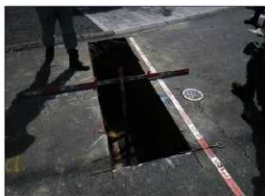
(14) No.1 トレンチ
