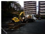
(25) アスファルト・ コンクリート除去風景
