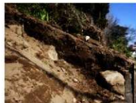
(32) 法面北側 工事完了状況
