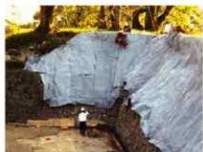
⑦保護シート（不織布）の設置
