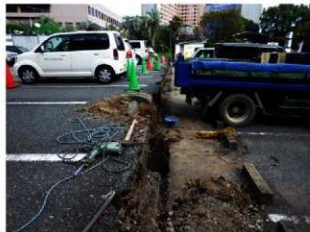
(12) 工事風景（西から）
