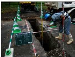
(14) No.5 トレンチ
