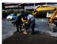
(25) 復旧, 砕石填圧
