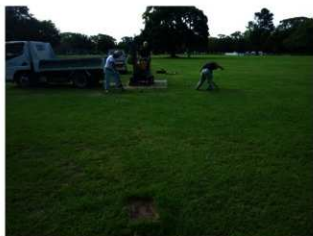
(13) 掘削作業状況
