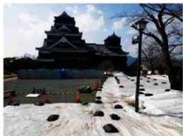
本丸広場の雨水対策シート養生
