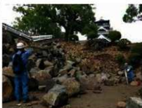
③崩落石材の測量（光景などのデジタル測量）
