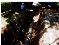
(6) 掘削風景 東から
