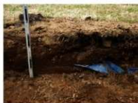
(33) 3月22日掘削断面(西側)
