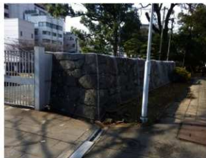
(24) 作業完了状況
