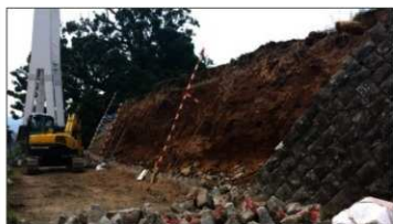
(7) 8月22日工事立会
