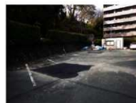
(25) アスファルト復旧
