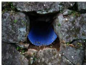
(5) 養生完了 東から
