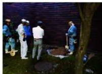
(11) ポイント2 掘削風景
