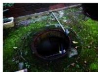
(11) ポイント2 掘削前ケーブル位置確認
