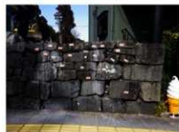
(32) 法面南側 南面石垣 (テープを貼った石材を撤去)
