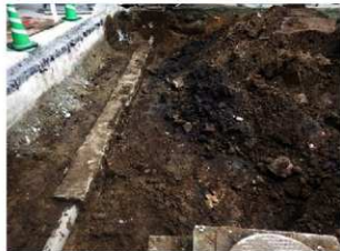
(34) 掘削基底の状況
