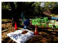
(11) ポイント1 掘削風景
