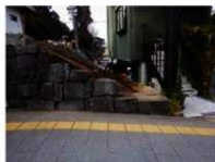
(32) 法面南側 南側石垣の石材撤去状況
