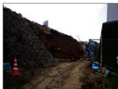
(7) 8月5日工事立会
