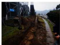
(33) 3月23日掘削風景
