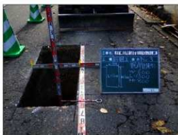
(14) No.3 トレンチ
