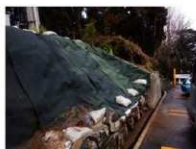
(32) 法面北側 工事完了状況
