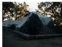
⑨防護ネットによる安全対策
