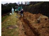
(33) 3月22日掘削風景
