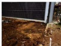
(28) ポイント1付近掘削
