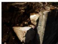
(32) 法面北側 ブロック敷に保護され 現状保存される東面石垣石材
