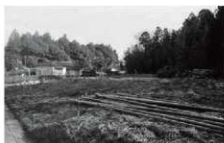
鳴神山道跡(第3地点) 調査前風景
