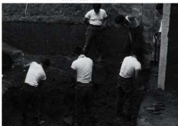
作業風景（西から）
