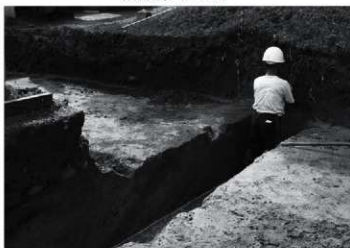
石垣背面盛土断面（北西から）
