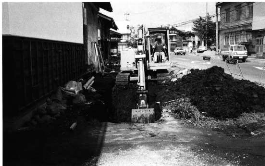
1. 表土除去作業開始 (第I地区)
