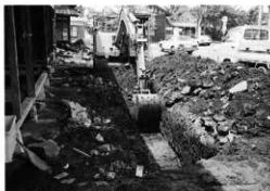
2. 表土除去作業 (第II地区)
