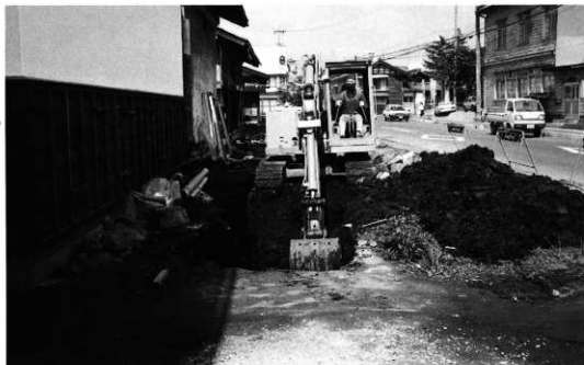
1. 表土除去作業開始 (第I地区)
