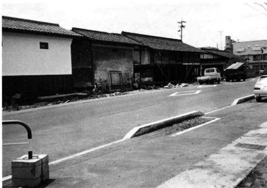
1. 菅田通路近景 (北東より)
