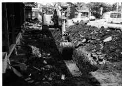
2. 表土除去作業 (第II地区)
