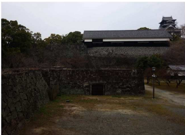
向埋御門石垣 被災前 南から
