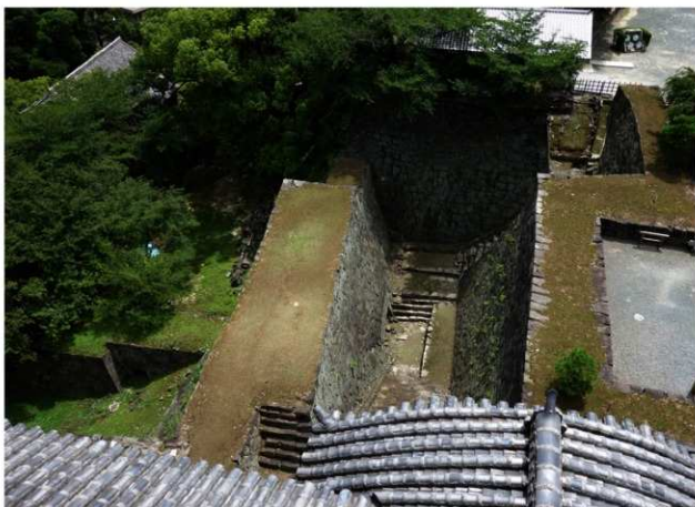
石門周辺石垣 被災前 上から
