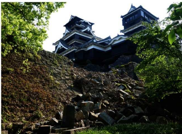
被災後 北東から
