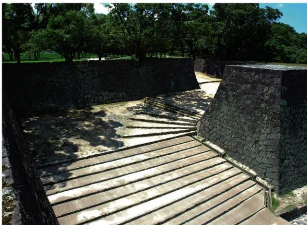
二の丸御門跡石垣 被災前 北東から
