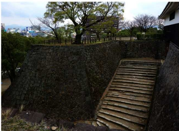
二ノ櫓御門跡石垣 被災前 北から
