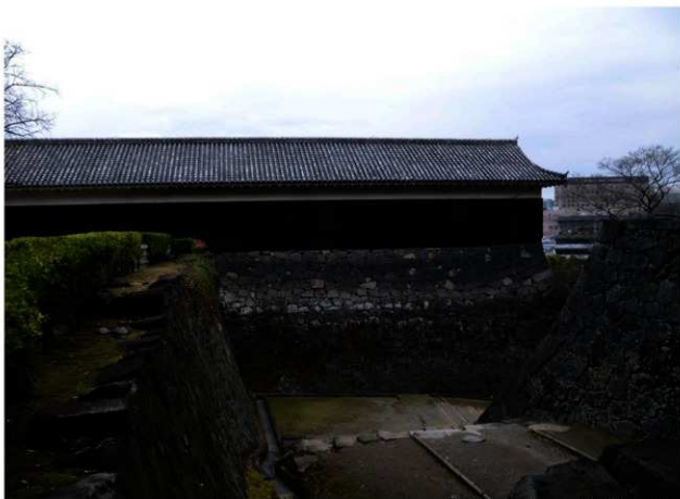
東十八間櫓西側石垣 被災前 西から
