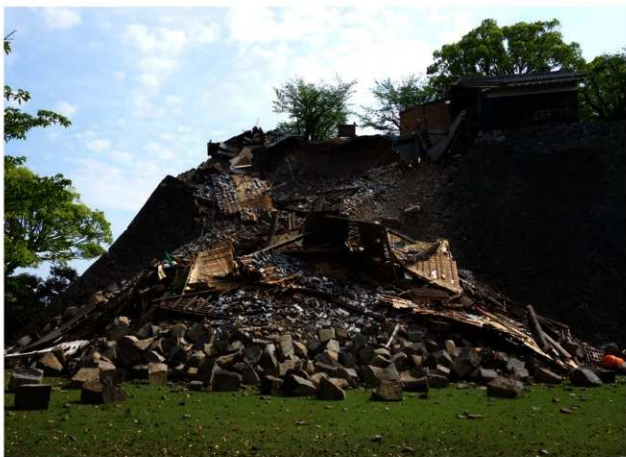
被災後 北から
