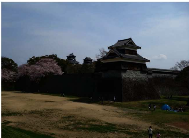
戊亥櫓周辺石垣 被災前 北西から
