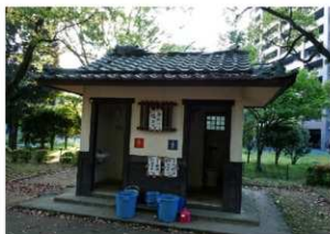
㉔古城堀端公園トイレ
