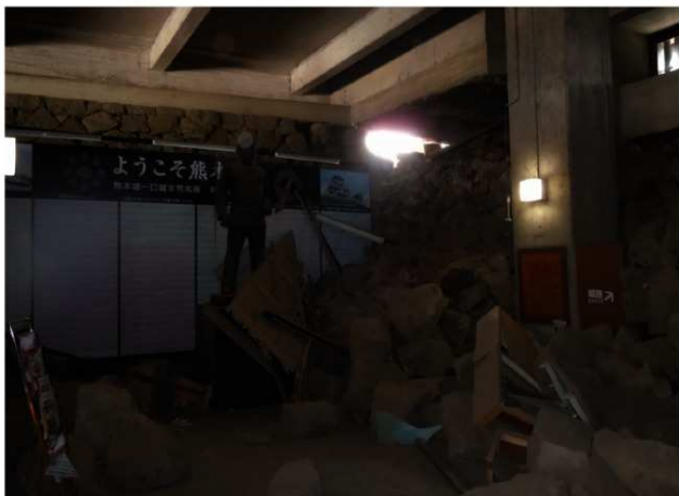
小天守穴蔵 被災後
