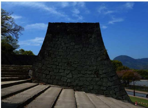
二の丸御門跡東側石垣 被災前 東から
