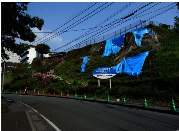
被災後 南東から
