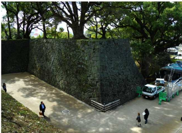
頼当御門周辺石垣 被災前 北東から
