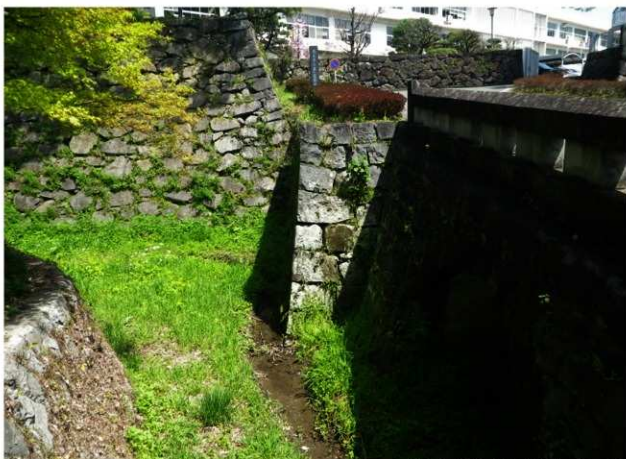
古城正面橋台石垣 被災前 南西から
