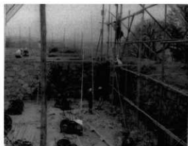
天守再建時の大天守通路閉塞と石垣再築
