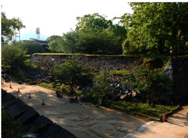
被災後 南東から
