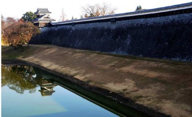
西出丸西側石垣 被災前 南西から
