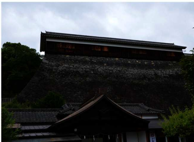
東十八間櫓東側石垣 被災前 東から
