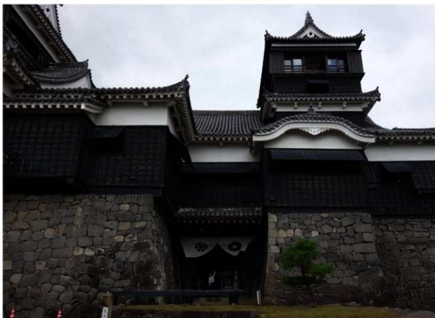
小天守入口石垣 被災前 東から
