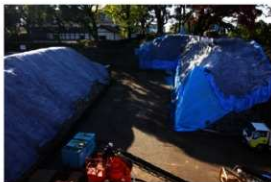
頬当御門口石垣養生作業
