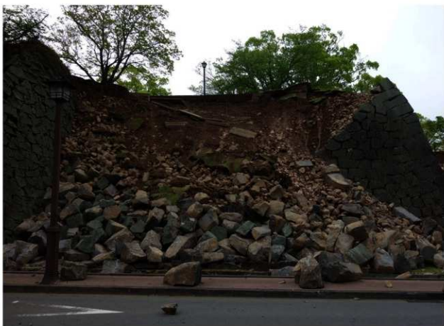
被災後 北から
