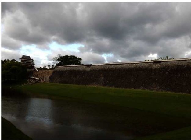
被災後 南西から
