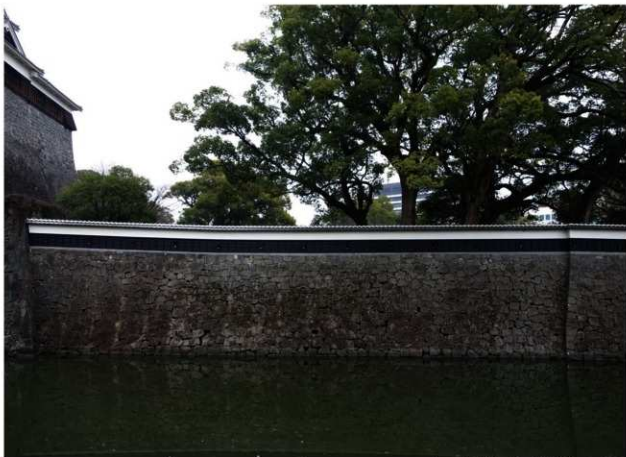
竹の丸西側石垣 被災前 西から
