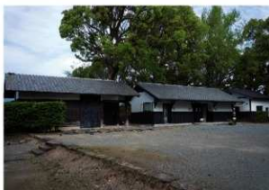
④⑤ 数寄屋丸多目的トイレ・電気室、数寄屋丸トイレ
