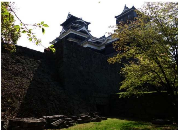
石門石垣 被災前 北東から
