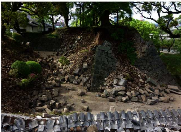
被災後 北から
