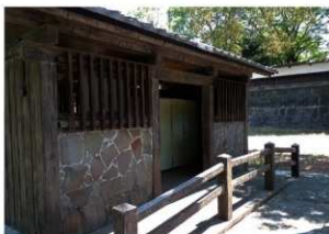
㉓三の丸広場北側トイレ
