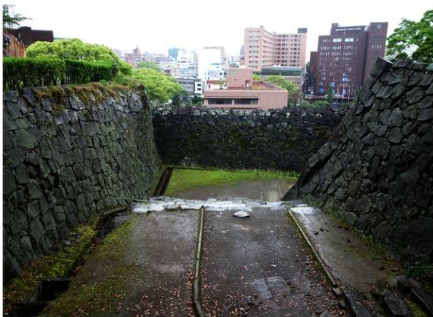
被災後 西から
