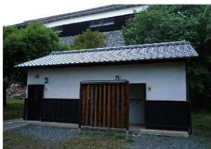
⑥ 飯田丸トイレ・ポンプ室
