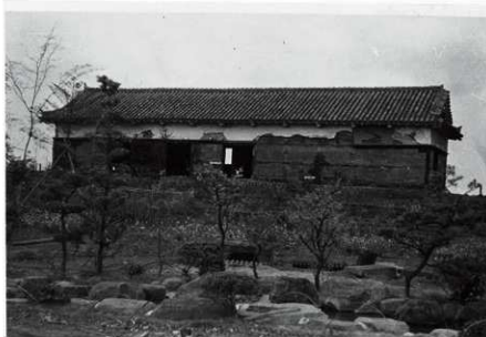
図 6-168 監物櫓昭和 28 年修理前南面
