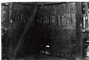
図 6-187 監物櫓修理中壁小舞 北西隅石落し
