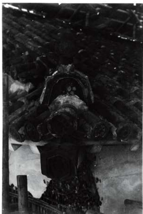
图 6-177 監物櫓修理前の屋根詳細 南西ノ隅
