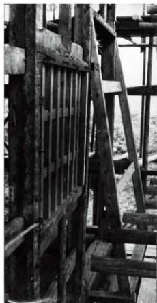
図6-115 田子櫓 石落外部構造 文化庁所蔵。
