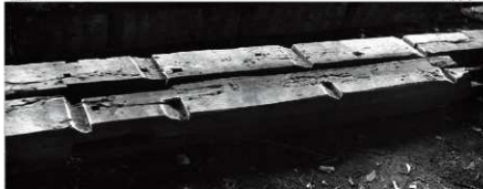
図 6-110 要旨二 入口両脇柱外面の壁笄掛仕口
