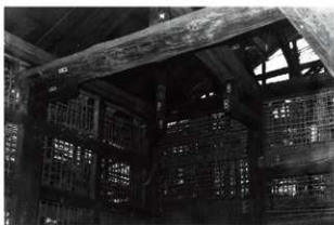
図 6-188 監物櫓修理中壁小舞 西南内部隔
