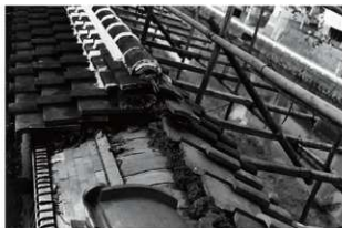
図6-202 昭和47年修理時の棧瓦葺状況
