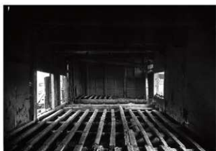
図 6-106 要旨一 七間檜内部 床が後世補強されている。文化庁所蔵。
