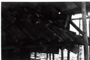
図 6-182 監物櫓修理前屋根詳細 北東ノ隅
