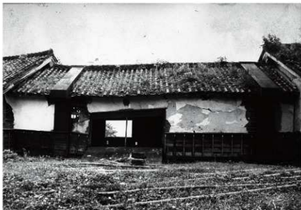
図 6-109 要旨二 西側入口 二開口に拡張されている。 文化庁所蔵。
