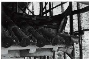
図 6-181 監物櫓修理前屋根詳細 南東ノ隅
