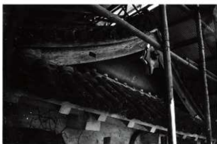
图 6-173 監物櫓修理前の屋根詳細 西ノ妻
