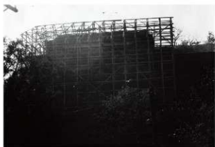
図 6-153 組立中の素屋根
