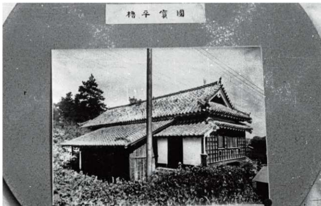
図6-144 昭和28年修理前の平櫓の写真の複写
