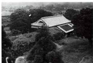
図 6-155 竣工の状態（西より）
