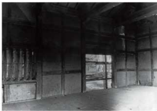
図 6-95 四間檜 昭和 32 年修理前内部西北面
