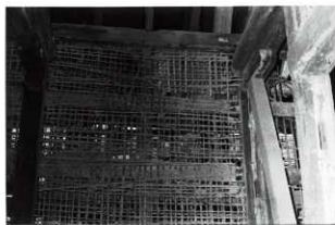
図 6-195 監物櫓修理中壁小舞 北側二重壁小舞
