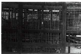
図 6-198 監物櫓修理中壁小舞 南側一重壁小舞
