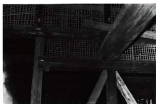
図 6-200 監物櫓修理中壁小舞 るへ二十ノ間仕切
