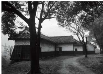
図 6-88 昭和33年修理前の源之進櫓北面
