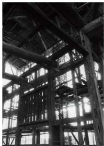
図 6-139 要旨四 五間檜内部東より第一間間仕切⑥ 又ノ四柱南面に残る間渡穴・ 壁貫穴。無目敷居下端には中 柱の痕跡がある。
