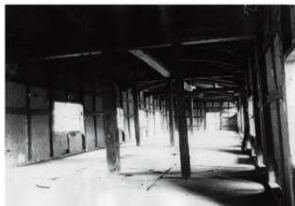
図6-103 十四間檜 昭和32年修理前 北面
