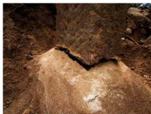
図 7-4 重要文化財長塙控柱破損状況(平成 22 年 12 月)
