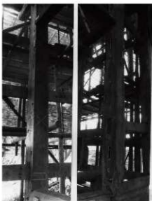
図 6-140 要旨四 五間檜 東より第一間の間仕切⑦ 又ノ四柱南面に残る間渡穴・壁貫穴・無目敷居欠込。 五ノ四柱北面床上端に残る無目敷居の欠込。
