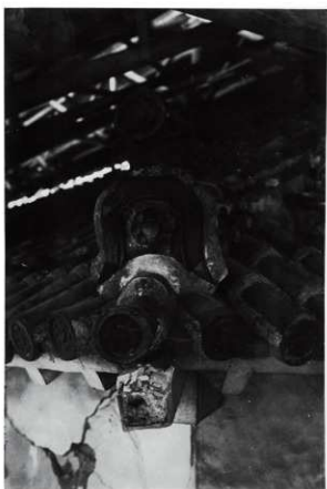
图 6-178 監物櫓修理前の屋根詳細 南東ノ隅
