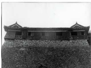
図 6-124 要旨二 北十八間櫓北面現状⑤ 西より第一、十間の窓を壁とする。
