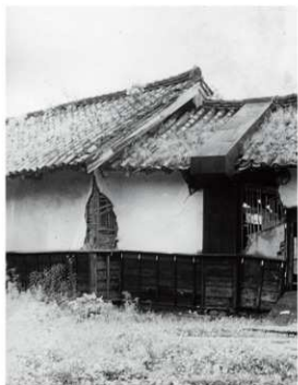
図6-104 十四間檜 昭和32年修理前 十四間檜と七間檜の接続部分。図6-99に比べて破損が顕著である。
