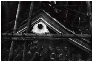
図 6-184 監物櫓修理前屋根詳細 東ノ妻
