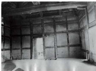
図 6-96 四間檜 昭和 32 年修理前内部北面
