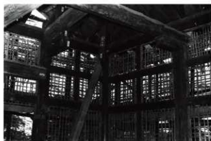
図 6-199 監物櫓修理中壁小舞 東南内部ノ隔
