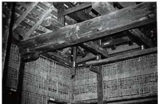
図 6-150 解体中の状況 1
