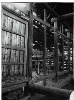
図 6-130 要旨四 北十八間櫓の十一柱、りの十一柱一 筋敷居・鴨居痕跡⑪
