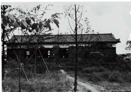
図 6-165 監物櫓昭和28年修理前南面
