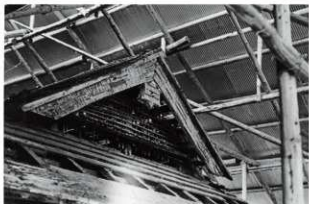
図 6-148 妻解体中の状況
