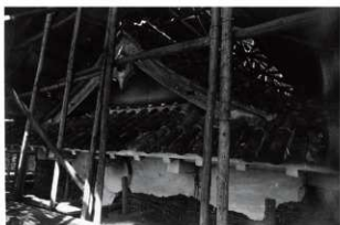
图 6-174 監物櫓修理前の屋根詳細 西ノ妻
