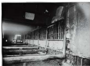
図 6-123 要旨一 北十八間櫓内部南面西より④ 内法間にある間渡穴跡。(三箇所ある)
