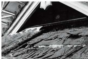
図 6-149 西妻瓦解体中の状況
