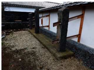
図7-8 馬具櫓及び続塙の控柱(基礎が見える部分)
