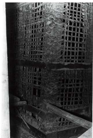
図 6-192 監物櫓修理中壁小舞 南東ノ隅柱壁下地
