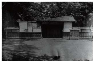
図 6-210 昭和30年櫓方門破損状況 西より
