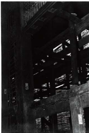
図 6-191 監物櫓修理中壁小舞 北側窓
