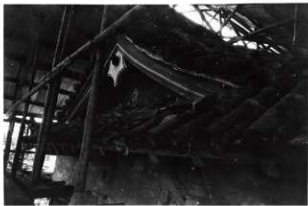
図 6-186 監物櫓修理前屋根詳細 東ノ妻
