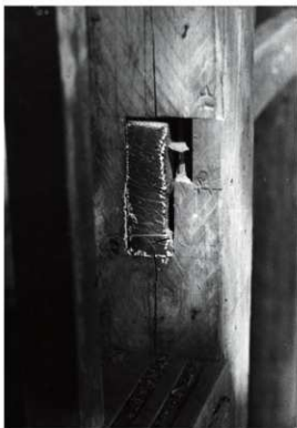
図 6-90 要旨一 四間櫓 貫の切り口よりみて後に切断されたと見られる。文化庁所蔵。
