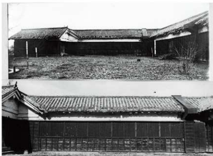
図6-120 要旨一 北十八間櫓南面全影① 窓全体を撤去し、壁とする。
