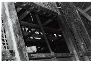
図 6-193 監物櫓修理中壁小舞 北側窓
