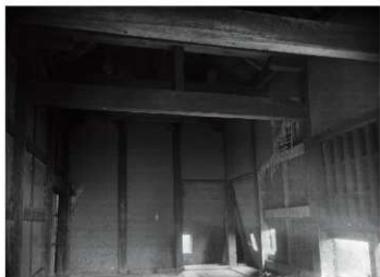
図 6-87 昭和33年修理前の源之進櫓内部南より
