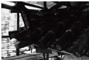
図 6-179 監物櫓修理前屋根詳細 南東ノ隅
