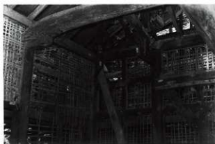
図 6-194 監物櫓修理中壁小舞 東北内部隔
