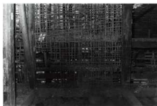
図 6-197 監物櫓修理中壁小舞 北側二重壁小舞
