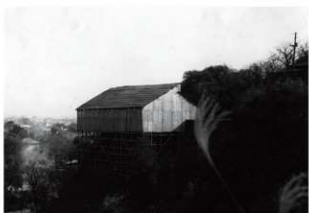
図 6-154 組み立てられた素屋根
