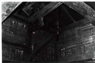
図 6-196 監物櫓修理中壁小舞 北西内部隔
