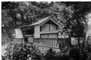
図 6-211 昭和30年櫓方門破損状況 南より
