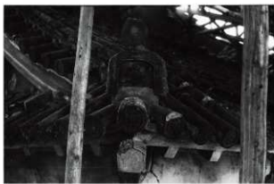
図 6-185 監物櫓修理前屋根詳細 北東ノ隅
