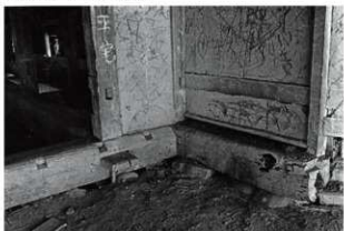
図 6-152 解体中の状況 3
