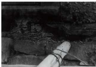
図 6-33 続櫓南東隅土台腐蝕（位置図 3 a ）
