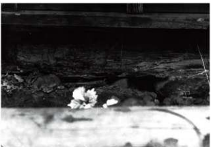
図 6-33 続櫓南東隅土台腐蝕（位置図 3 a ）
