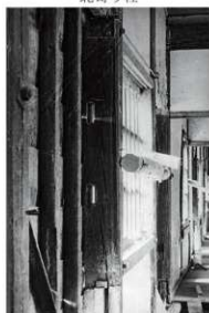
図6-14 要旨三(ハ)1 続櫓西側、南より第二窓柱抱合せ面(半間窓を設ける)。文化庁所蔵。
