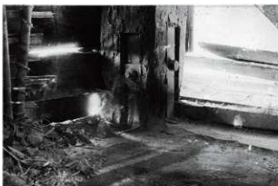
図 6-79 宇土槽西北隅柱☆
