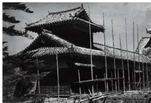
図 6-73 二階櫓東南隅(修理前) ☆
