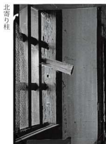
図6-13 要旨三(ロ) 続櫓西側、中央一間窓柱抱合せ面。 北寄り柱は壁、西寄り柱は窓(半間窓の痕跡)。文化庁所蔵。
