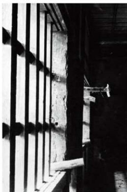
図6-24 要旨一 修理前 窓の間 もとは壁であったので古い壁、間渡穴が ある(上:埋木、下:穴)。文化庁所蔵。
