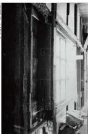
図 6-7 要旨一(ロ) 2 西側、北より第五の間（中央窓の南隣りの間）柱抱合せ面（もと窓の痕跡）。文化庁所蔵。
