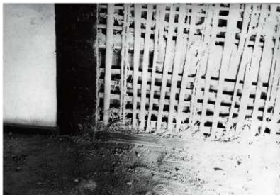
図 6-25 要旨二 (イ) 腰貫に残る旧銃眼欠 1 統櫓西側南より「第十一間」。文化庁所蔵。
