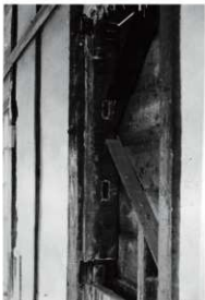
図 6-9 要旨一(ハ) 2 東側、北より第四の間北寄りの柱（もと窓の痕跡）。文化庁所蔵。
