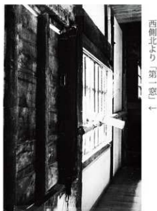
図6-12 要旨三(イ) 2 続櫓西側、北より第三間北寄り柱(もと窓の痕跡)。文化庁所蔵。
