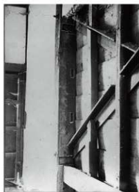
図6-13 要旨三(ロ) 続櫓西側、中央一間窓柱抱合せ面。 北寄り柱は壁、西寄り柱は窓(半間窓の痕跡)。文化庁所蔵。
