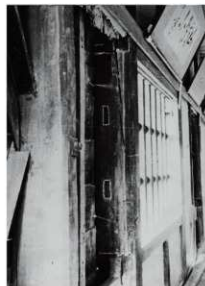
図6-3 要旨一(イ)2 北側、東より第七の間のもと窓の痕跡。文化庁所蔵。
