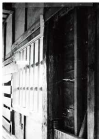
図6-2 要旨一(イ)1 北側、東より第七の間のもと窓の痕跡。文化庁所蔵。
