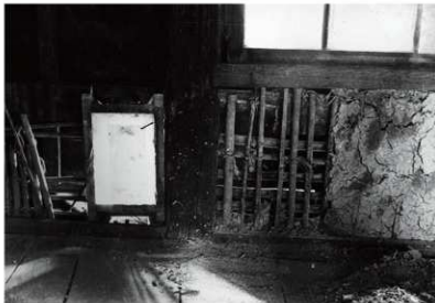
図 6-27 要旨二 (イ) 腰貫に残る旧銃眼欠 3 統櫓南より「第三間」。左は現存銃眼。 文化庁所蔵。
