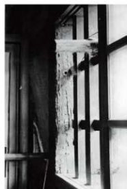
図 6-8 要旨一(ハ) 1 東側、北より第二の間北寄りの柱（もと壁の痕跡）。文化庁所蔵。
