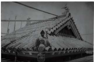
図 6-55 宇土櫓三層西南より
