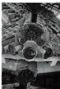
図 6-70 三層南東下り棟正面
