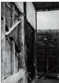
図6-14 要旨三(ハ)1 続櫓西側、南より第二窓柱抱合せ面(半間窓を設ける)。文化庁所蔵。
