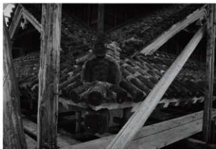
図 6-47 二層北西下り棟正面
