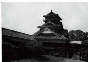
図 6-39 宇土櫓南東より
