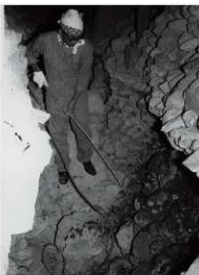
図 6-83 石垣裏込への防蟻処理
