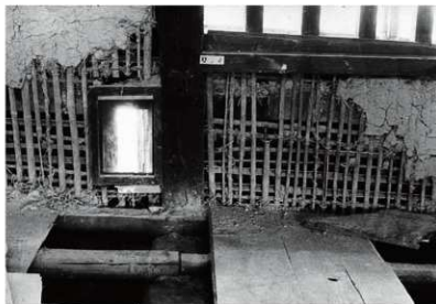
図 6-29 要旨二 (口) 続檜腰貫に残る旧銃眼欠 2 右：腰貫に残る旧銃眼欠。 左：上の図の現存のもの。 文化庁所蔵。
