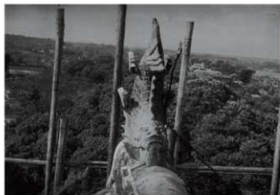
図 6-46 宇土櫓北側鯨南より
