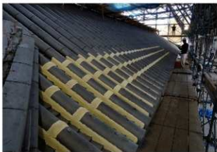
図 4-154 馬具櫓 屋根工事 目地漆喰施工中
