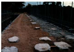
図 4-28 基礎工事 2階礎石据付完了
