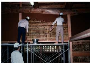
図 4-67 左官工事 二の間の内壁荒壁塗
