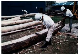
図 4-32 木工事 梁チョウナ掛
