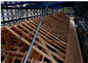
図 4-148 馬具櫓 木工事 垂木・野地板組立
