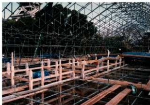
図 4-39 木工事 小屋梁他組立
