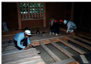
図 4-50 木工事 板の間 床板張り
