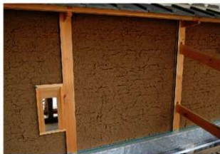
図 4-171 統塀 左官工事 荒壁付け
