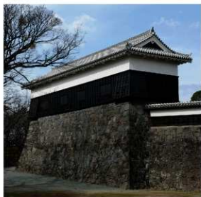
図 4-178 馬具櫓 竣工 東南より
