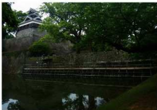
図 4-162 続塙 仮設工事 備前堀側足場組立
