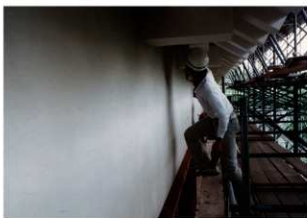
図 4-74 左官工事 南面外壁漆喰仕上げ
