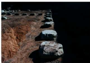
図 4-27 基礎工事 1階礎石据付完了
