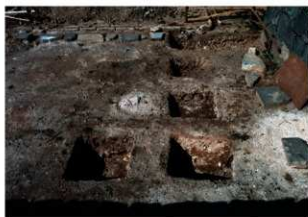
図 4-26 基礎工事 礎石版築作業
