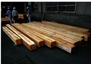
図 4-144 馬具櫓 木工事 柱材検査
