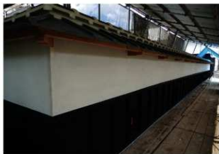
図 4-173 統塀 左官工事 外側漆喰仕上げ
