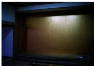
図 4-84 雑工事 床の間金箔押し完了
