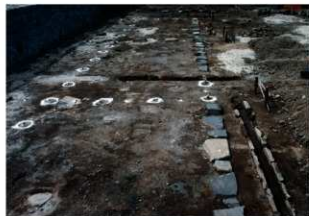
図 4-24 基礎工事 1階礎石位置出
