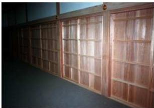
図 4-80 建具工事 二の間、三の間 板戸
