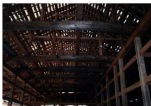
図 4-44 木工事 2階内部(三の間上部)
