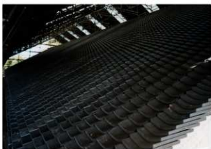
図 4-58 屋根工事 南面屋根平瓦葺完了
