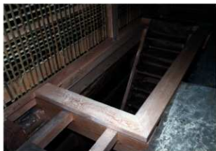
図 4-48 木工事 階段取付
