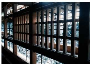
図 4-46 木工事 2階窓格子組立
