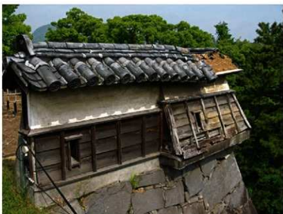
図4-7 コンクリートブロック造による平左衛門丸堀（平成23年）
