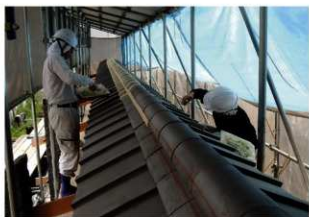
図 4-169 統塀 屋根工事 目地漆喰塗
