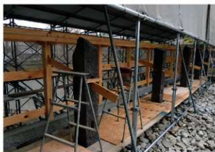
図 4-167 統塀 木工事 控貫組立
