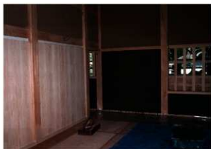
図 4-68 左官工事 板の間中塗
