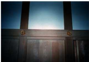
図 4-77 金具工事 釘金物(釘隠)取付
