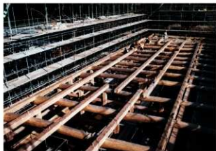
図 4-38 木工事 大梁組立
