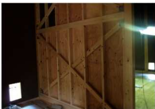
図 4-160 馬具櫓 好悪図補強工事 補強壁組立
