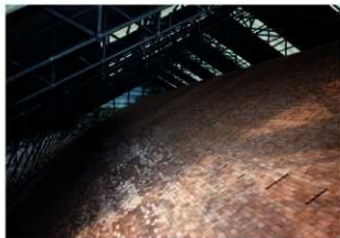
図 4-56 屋根工事 南面屋根土居葺完了
