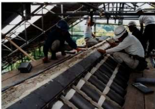
図 4-60 屋根工事 棟製斗瓦取付 (1段目)
