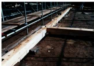
図 4-36 木工事 1階土台敷
