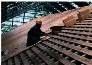
図 4-55 屋根工事 土居葺施工中
