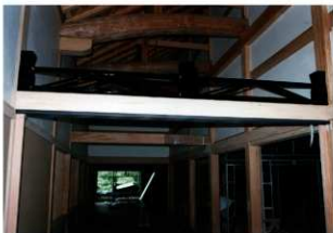
図 4-78 建具工事 廊下竹の節欄間組立
