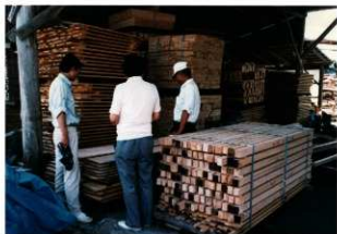
図 4-31 木工事 木材検査(寄材他)
