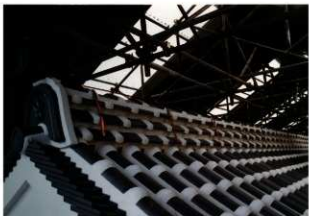
図 4-61 屋根工事 目地塗喰仕上、避雷針棟上導帯取付完了
