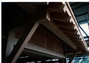
図 4-47 木工事 庇組立完了
