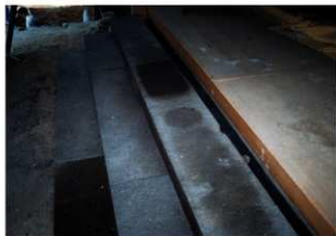
図 4-86 雑工事 廊下出入口石階段取付
