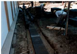
図 4-87 雑工事 外部排水溝石留付
