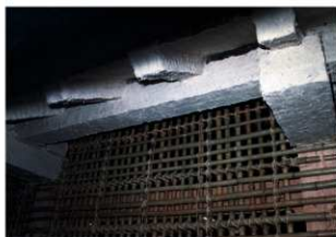
図 4-66 左官工事 軒先壁籠
