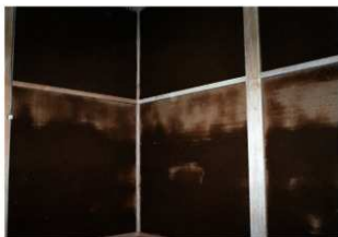
図 4-69 左官工事 次の間土壁乾燥
