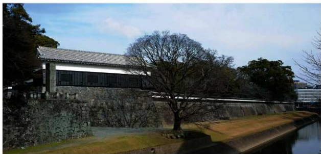
図 4-177 馬具櫓及び長塀 竣工 南面
