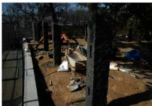
図 4-165 続塙 石工事 控柱据え付け
