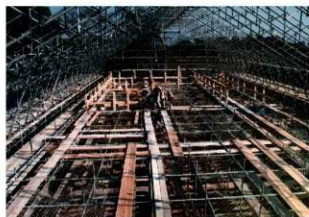
図 4-22 仮設工事 2階内部足場組立
