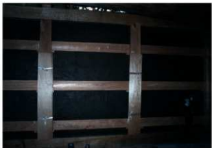
図 4-65 左官工事 1階荒壁塗裏返し
