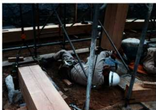
図 4-35 木工事 1階柱ひかり付け作業
