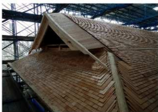
図 4-150 馬具櫓 屋根工事 土居葺
