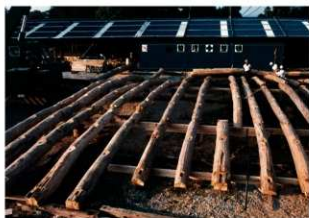
図 4-34 木工事 大梁仮組作業
