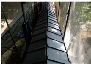
図 4-168 統塀 屋根工事 目板瓦葺
