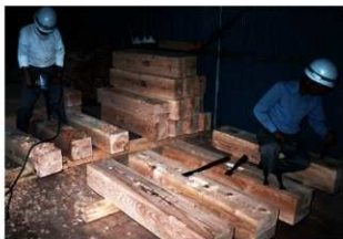
図 4-33 木工事 肘木加工
