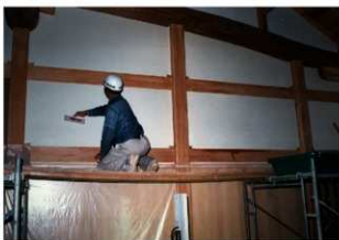
図 4-75 左官工事 板の間壁漆喰仕上げ
