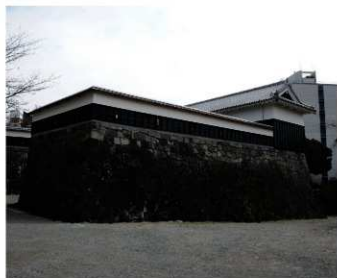
図 4-179 馬具櫓 竣工 西北より
