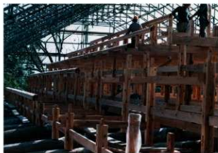
図 4-40 木工事 母屋、椽木組立
