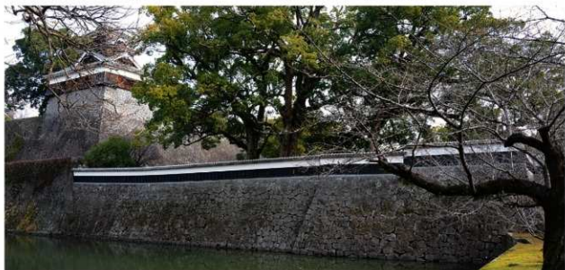
図 4-180 統塀（備前堀側）竣工 西面
