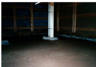
図 4-29 基礎工事 1階土間 三和上下地均
