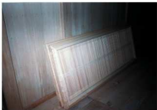
図 4-81 建具工事 波欄間搬入
