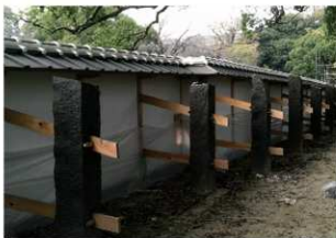
図 4-172 統塀 左官工事 内側漆喰仕上げ
