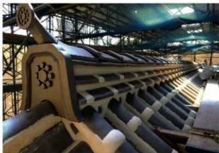
図 4-155 馬具櫓 屋根工事 大棟施工完了
