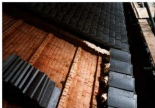
図 4-57 屋根工事 軒平瓦・平瓦葺
