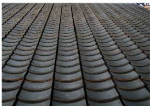
図 4-151 馬具櫓 屋根工事 平瓦葺き上げ
