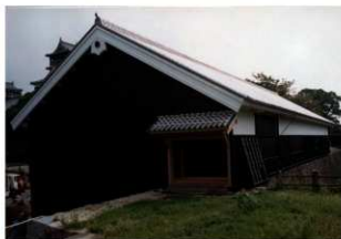
図 4-89 竣工 外観（西面）
