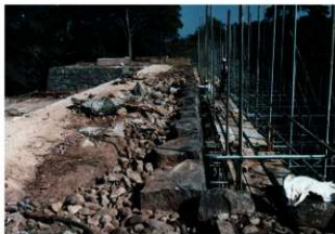
図 4-25 基礎工事 南面石垣補修
