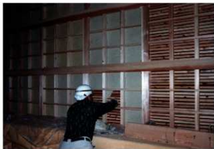
図 4-73 左官工事 床の間の壁塗下塗
