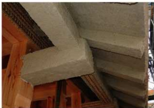
図 4-156 馬具櫓 左官工事 揚子漆施工中
