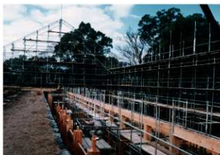
図 4-37 木工事 1階軸組立
