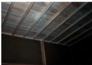
図 4-51 木工事 階段の間 天井板張り
