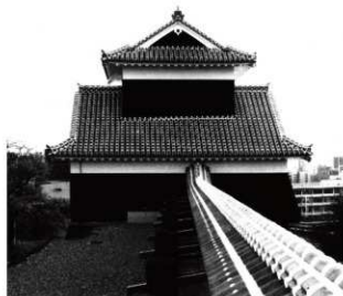
図 4-103 未申櫓外観 北より
