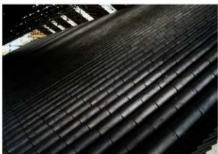
図 4-59 屋根工事 南面屋根丸瓦葺
