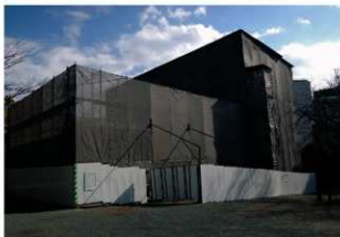
図 4-163 馬具櫓・続塙 仮設工事 素屋根完了
