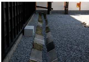
図 4-143 馬具櫓 石工事 両落側満完了
