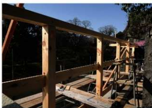
図 4-166 統塀 木工事 柱組立
