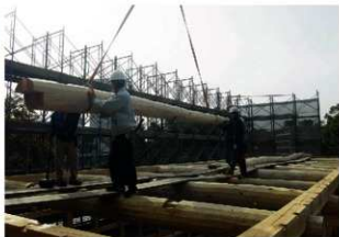
図 4-147 馬具櫓 木工事 敷梁組立
