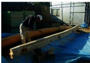
図 4-145 馬具櫓 木工事 大梁手新加工
