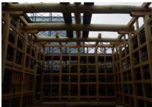
図 4-146 馬具櫓 木工事 柱組立状況
