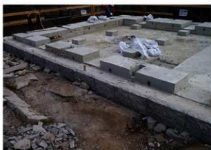
図 4-142 馬具櫓 石工事 地覆石据え付け
