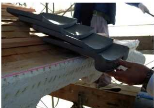
図 4-152 馬具櫓 屋根工事 軒先納まり確認
