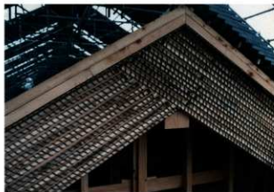
図 4-70 左官工事 西面破風板巻竹打完了
