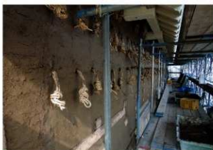
図 4-158 馬具櫓 左官工事 荒壁付け
