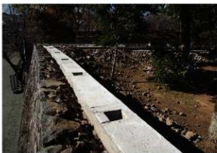
図 4-164 続塙 基礎工事 構造補強用基礎完了
