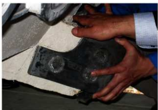
図 4-153 馬具櫓 屋根工事 網木蓋再利用
