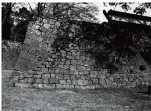
図 3-20 平御櫓西側着工前
