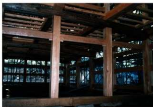
図 4-43 木工事 1階内部(土間1、2)
