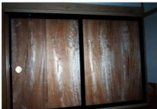
図 4-79 建具工事 杉板戸建付
