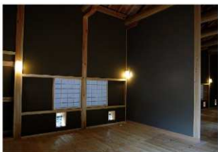
図 4-161 馬具櫓 構造補強工事 補強壁完了
