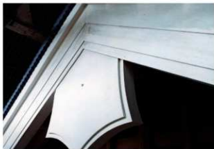
図 4-71 左官工事 東面破風漆噴仕上げ
