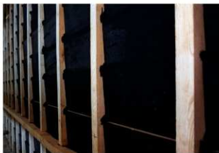
図 4-49 木工事 妻壁下見板取付
