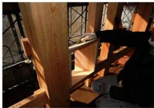
図 4-149 馬具櫓 木工事 狭間取り付け
