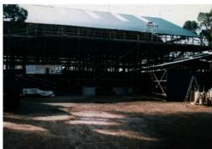
図 4-23 仮設工事 素屋根完了
