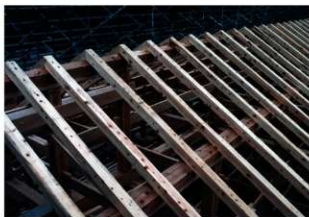
図 4-41 木工事 垂木取付完了
