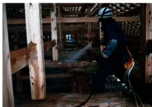
図 4-82 雑工事 小屋梁防蟻処理
