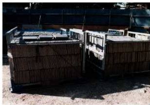
図 4-54 屋根工事 瓦搬入
