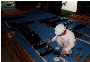
図 4-76 塗装工事 竹の節欄間カシュー下塗
