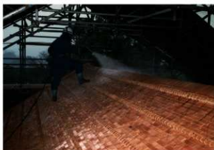
図 4-83 雑工事 屋根土居葺面防蟻処理
