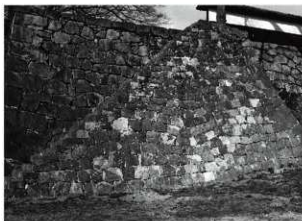
図 3-21 平御櫓西側竣工
