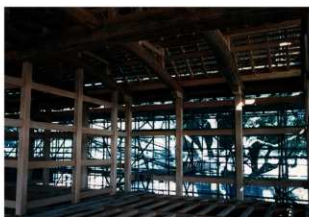
図 4-45 木工事 2階内部(板の間)
