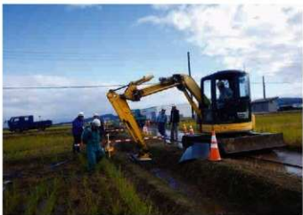
鬼倉遺跡 2トレンチ調査風景 (西から)
