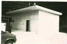
冷凍施設（浜田港）
