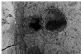
4区26P・27P全景
