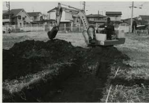
2. トレンチ掘削状況
