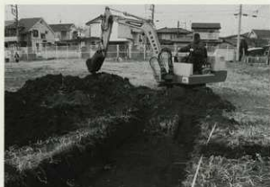
2. トレンチ掘削状況
