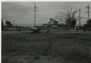
1. 小板橋遺跡c地点調査区近景
