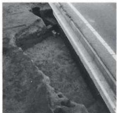
第1号竪穴住居跡完掘 (W→)
