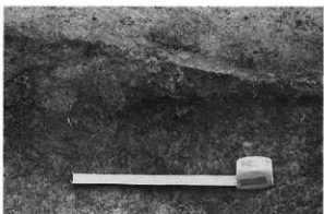
616土 南西隔壁面青灰色化状況(北から)
