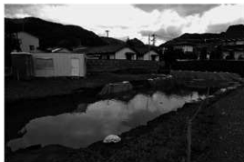
台風19号で水没した現場
