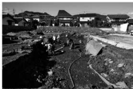
復旧作業風景
