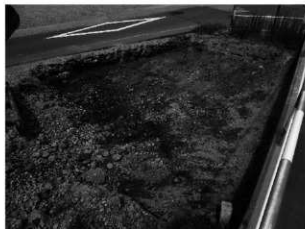
C区 表土掘削状況
