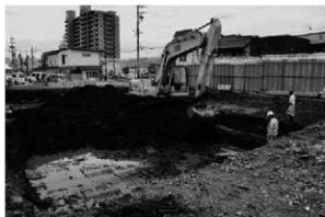
写真1 表土掘削 (7月4日)
