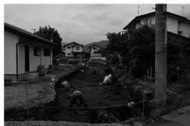
作業風景(A区)
