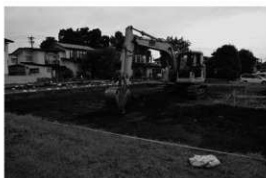
B区重機表土除去
