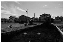
A区重機表土除去
