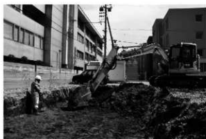
重機表土剥ぎ
