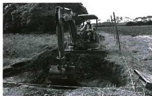
4. 植松遺跡 表土剥ぎ状況
