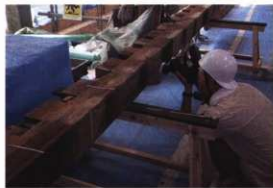
薬師寺東塔での調査
