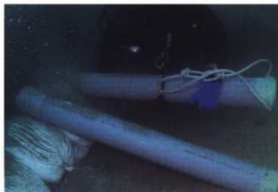
図2 潜水士による埋め戻し作業の様子
