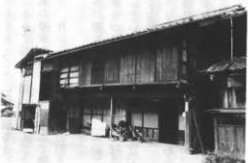
出桁造—母屋で糞垂をするために二階部分を広くとり、三尺ほど桁が前へ出ている。(中里) (撮影 根岸謙之助)
