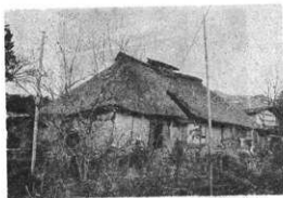
横坂 始家 (S9) 正面屋根の切落しは明治になってからの改造
