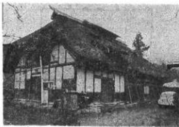
小林 辰蔵家 (S) 台所側の妻屋根を「カブト屋根」の形式にして妻側より小屋裏採光を計る正面の屋根の切上げは最近の改造による
