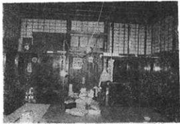
小林 功家「茶の間」カモイ上のショーシ部分は土壁となり天井は吹抜けとなる
