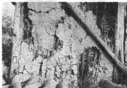
横坂始家の外壁（壁心はコマイ竹を使用せずして、横は雑木を使用し、縦はこれに草の茎をたばねてゆわえ、土を塗ったもの）
