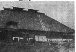
桑原 享家 (S) 正面屋根の一部切落しは後の改造による
