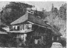
新木 博家 (S) 屋根の段違いは後の改造による
