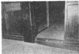
中村 輔家 茶の間と台所境の敷居に取っ手がついており夏になって畳を使用しなくなった場合簡単に取はず出来る様工夫されている。
