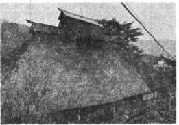
角田 福方家 (S) 棟の「ヤヅラ」も草葺とするため重厚さを感じさせる。(この地方の特徴である)
